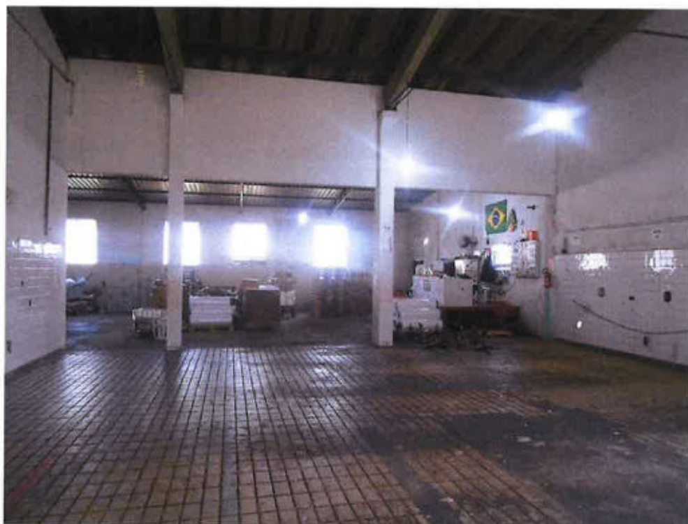
(Galpão de trabalho desocupado)
