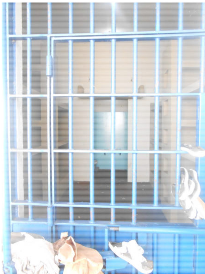
(Cela nº 1 desocupada no raio 7)
