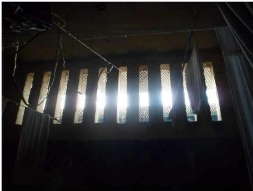
Fresta de entrada de ventilação e iluminação
