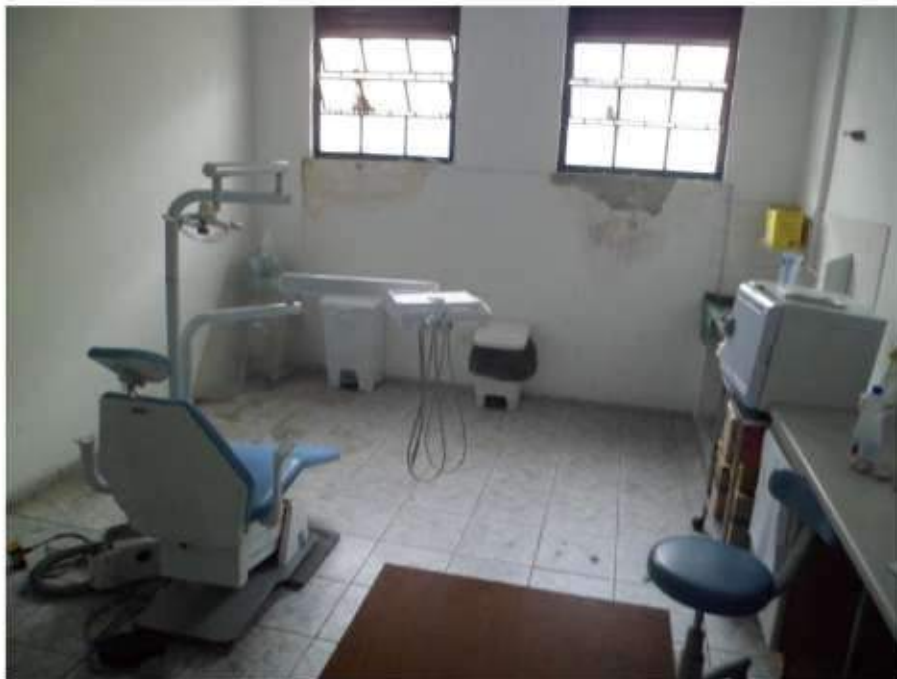
Sala de dentista em estado precário
