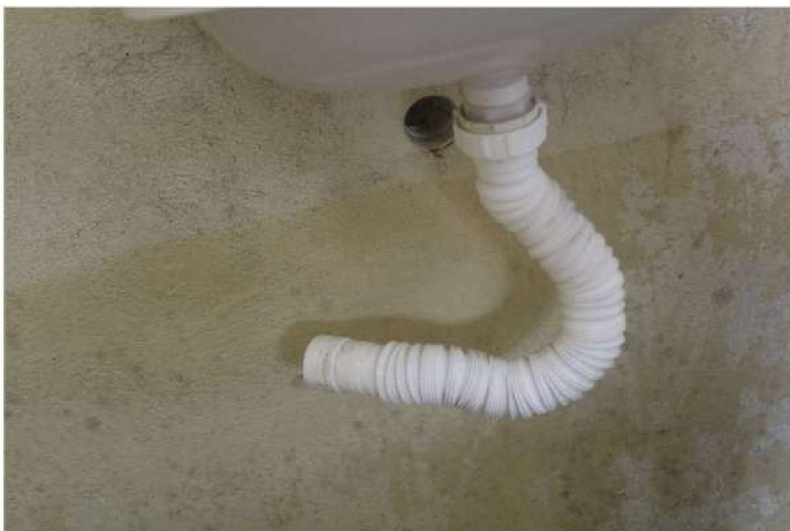
(Sifão de pia desinstalado no interior da cela)
