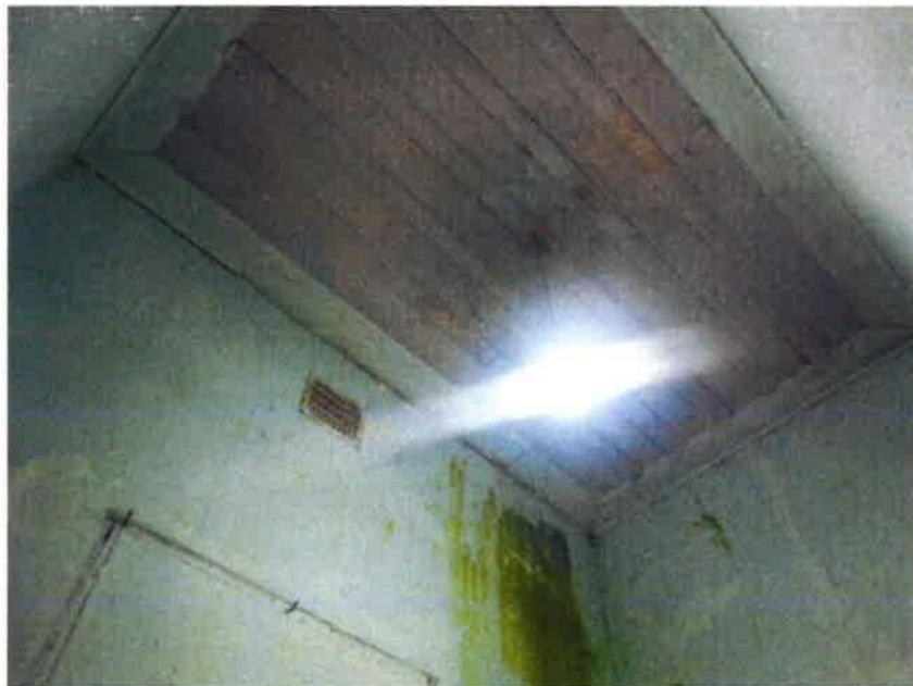
(Interior do banheiro)
