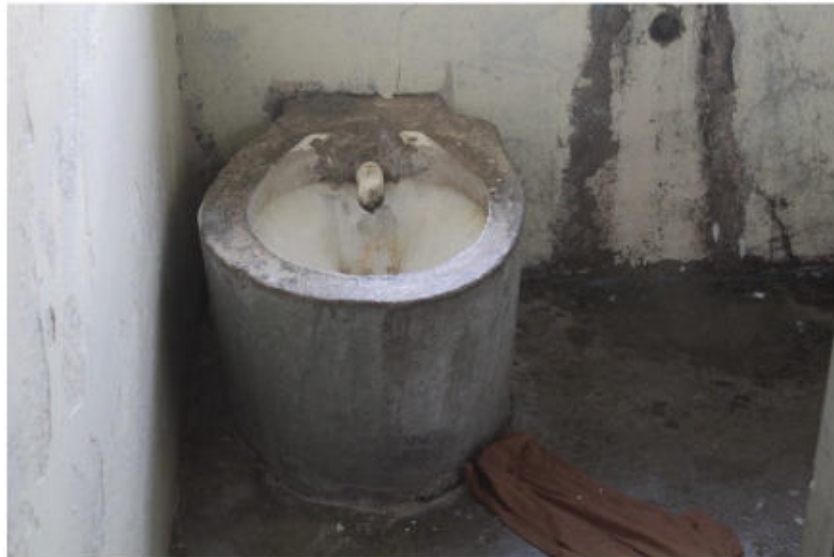
Detalhe de vaso sanitário em cela da enfermaria
