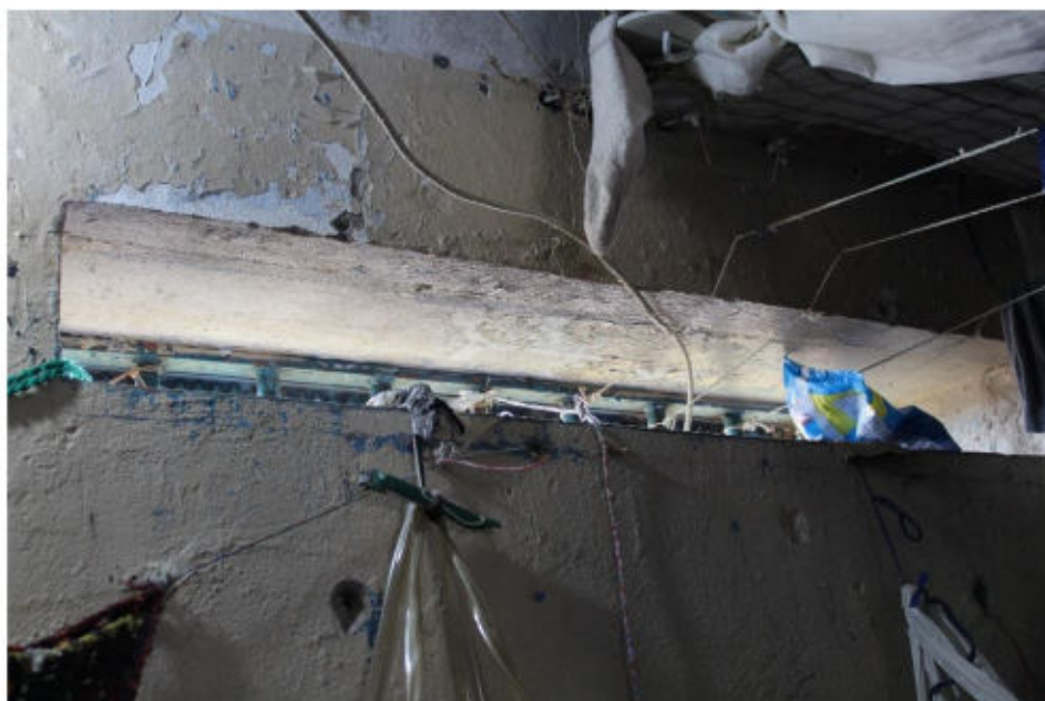
Detalhe para a pequena claraboia no fundo das celas que permite uma precária ventilação cruzada
