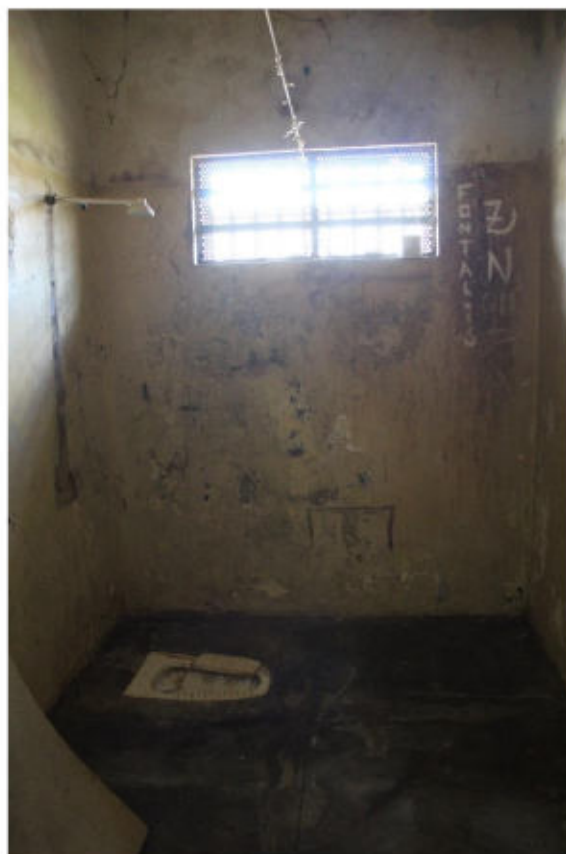
Interior de uma das celas do setor disciplinar. Detalhe para o chuveiro colocado sobre o vaso sanitário
