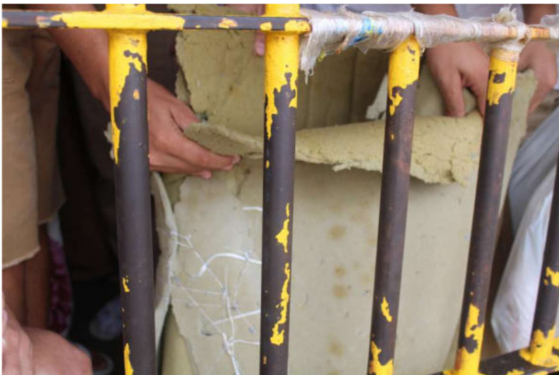
Situação dos "colchões".
