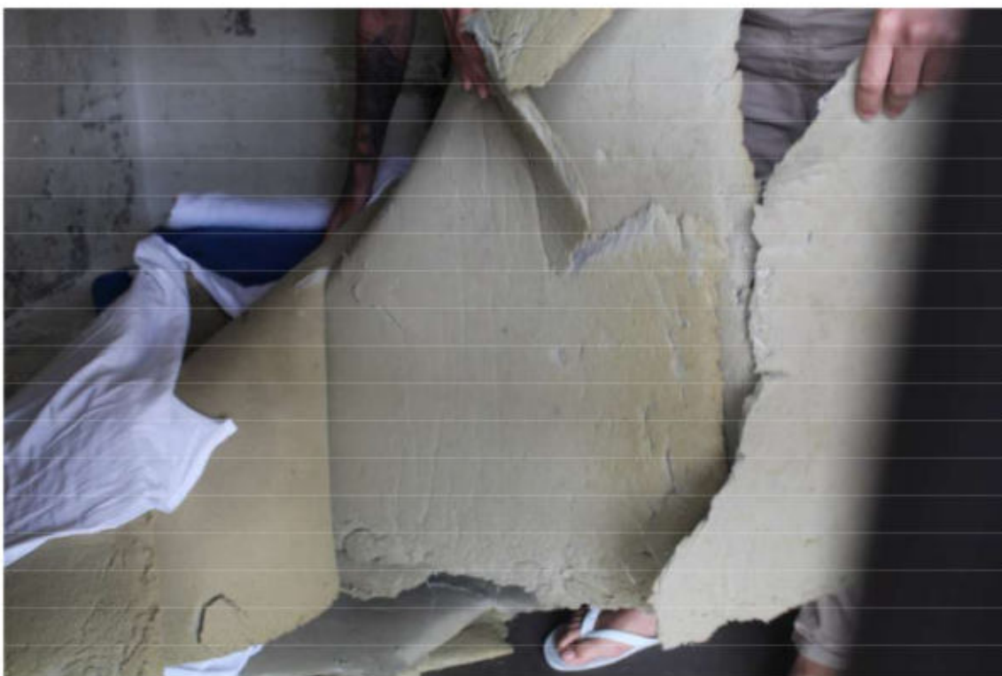
Situação dos "colchões".
