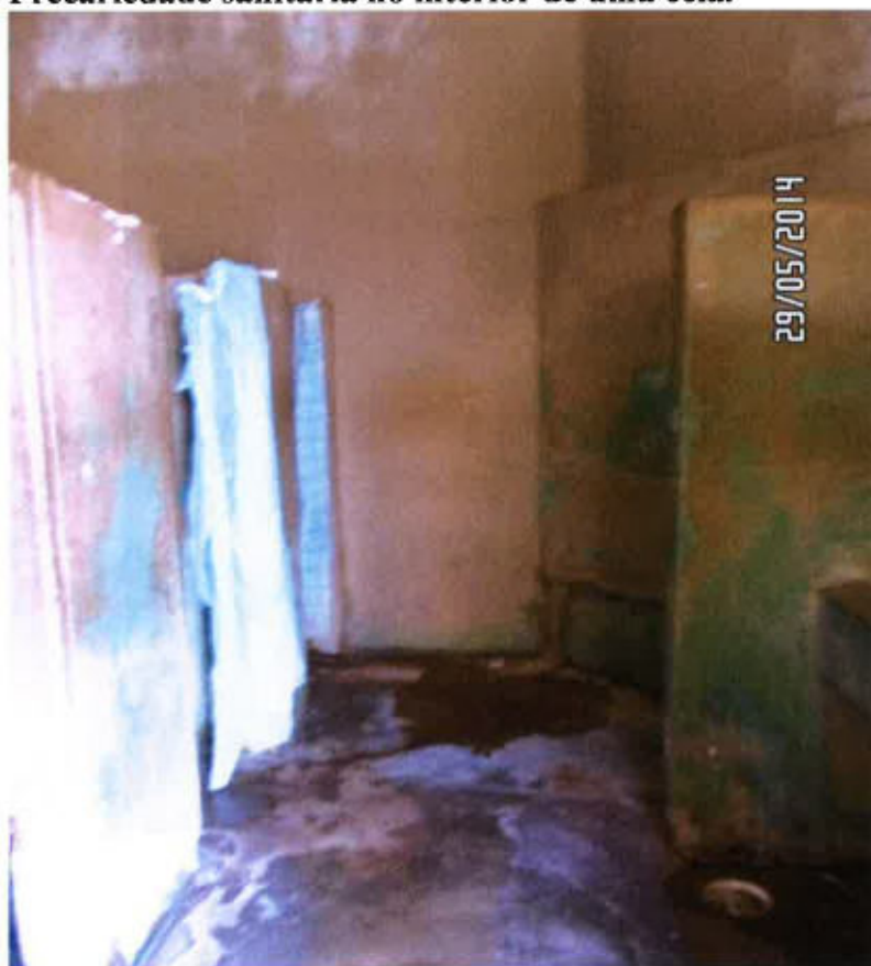
Banheiro de uso coletivo.
