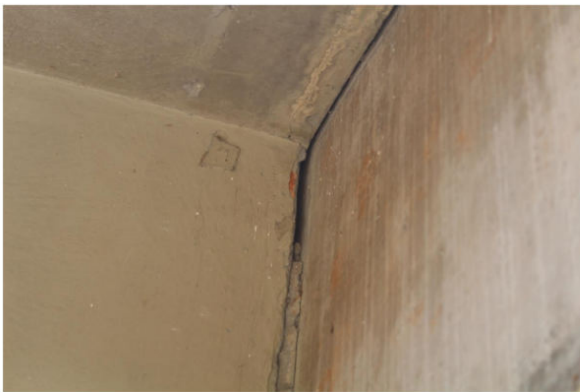
Água escorrendo entre a parede e o teto numa das celas.
