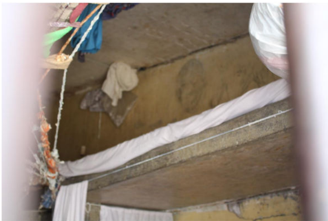
Toalha e cobertos sendo usados para estancar a vazão de água que vem do teto diretamente no leito de um detento.
