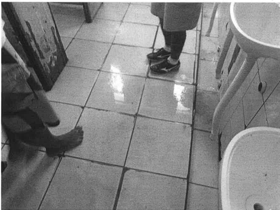
Figura 23 Pias sem encanamento
