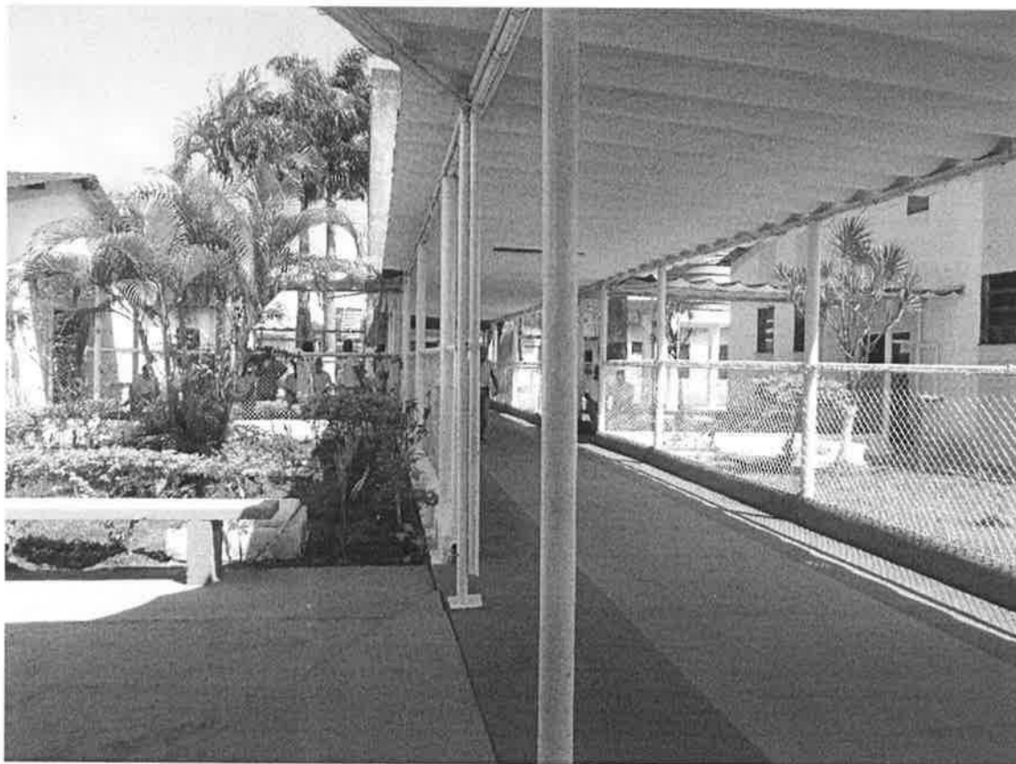
Figura 3 Entrada dos setores de detenção
