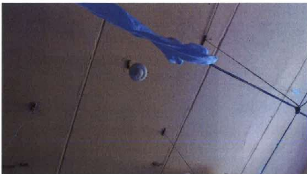
Figura 38 Ligação elétrica exposta – Cella do convívio
