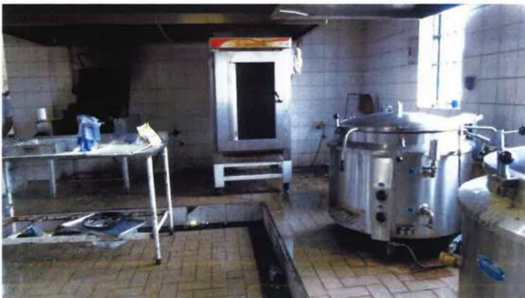
Figura 15 Vista Geral da Cozinha (2)
