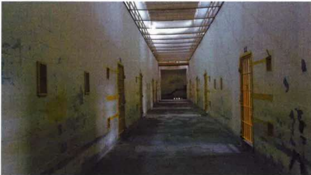
Figura 11 Corredor do pavilhão desativado
