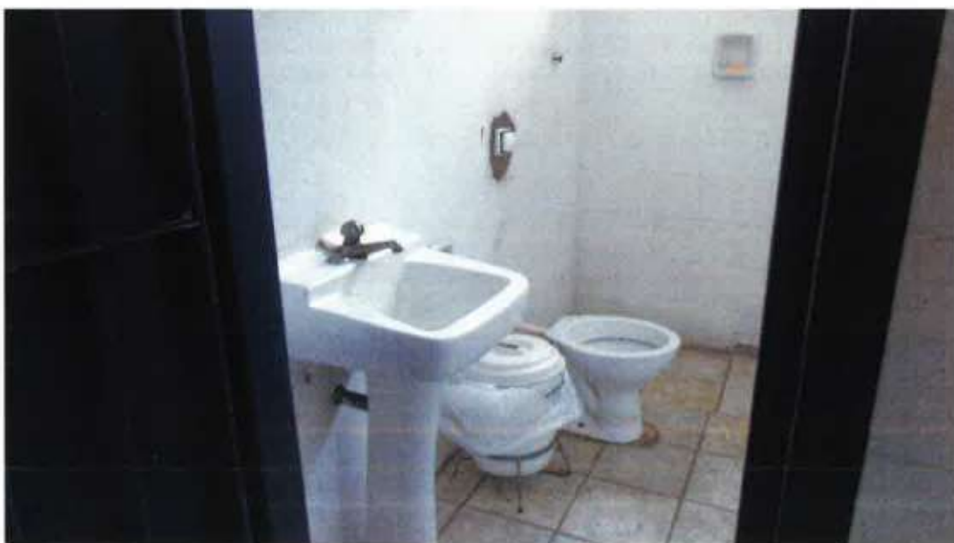
Figura 30 Banheiro da enfermaria
