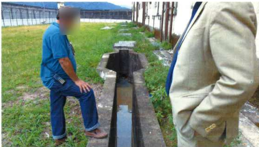
Figura 47 Esgoto a céu aberto ao lado das celas
