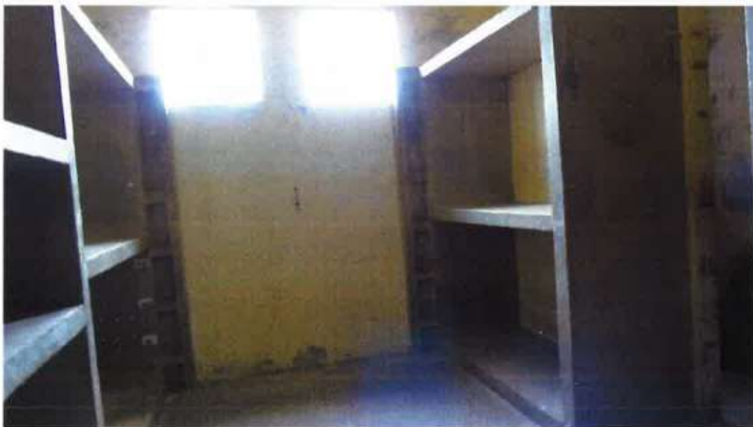
Figura 12 Cella do pavilhão desativado
