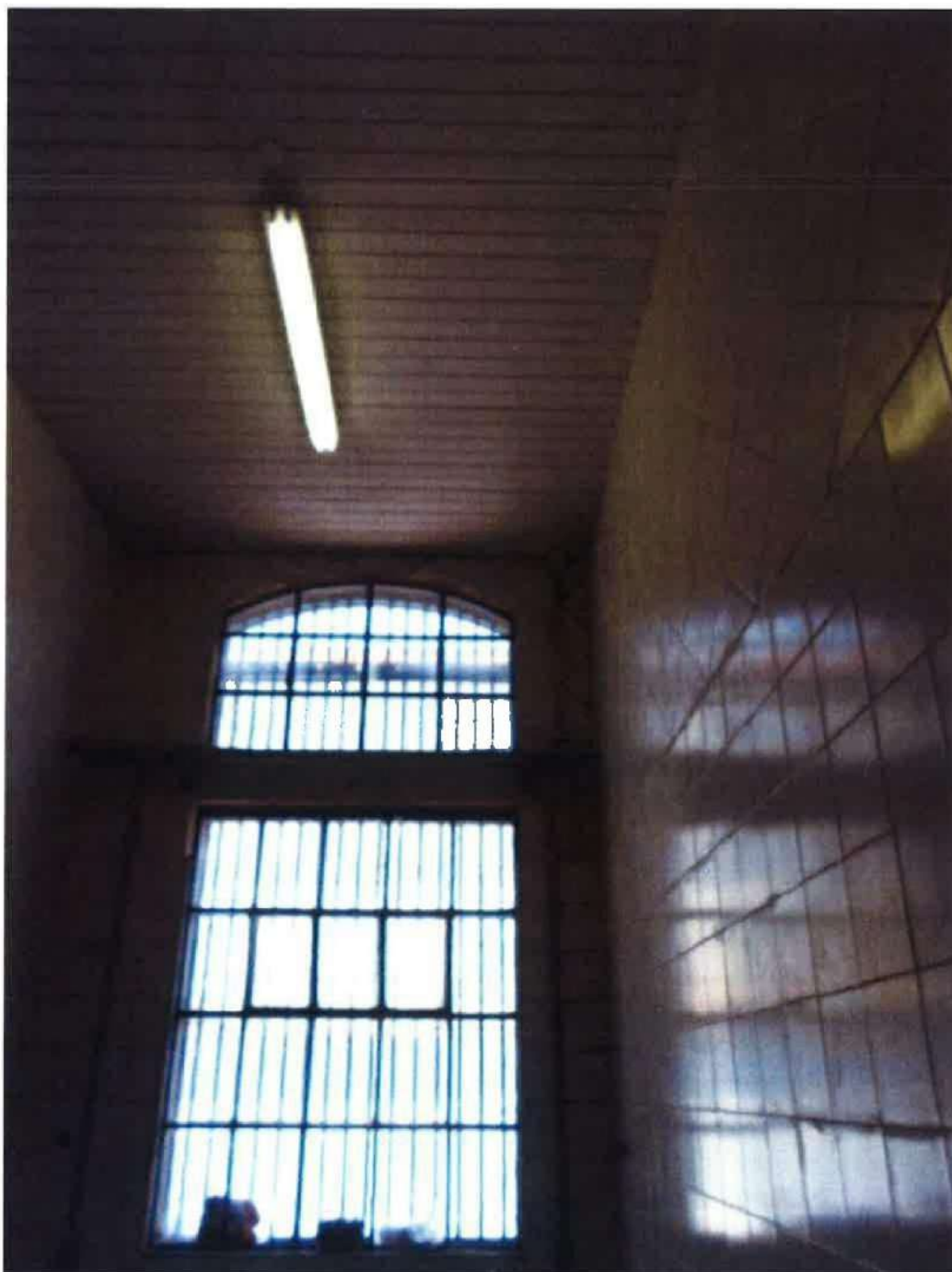
Paredes e janela da cozinha
