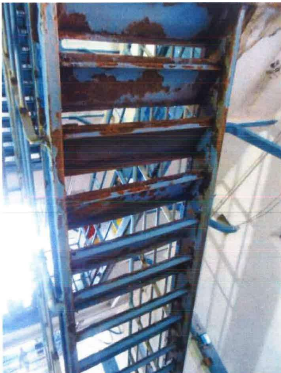
Escadaria de acesso entre os andares do pavilhão
