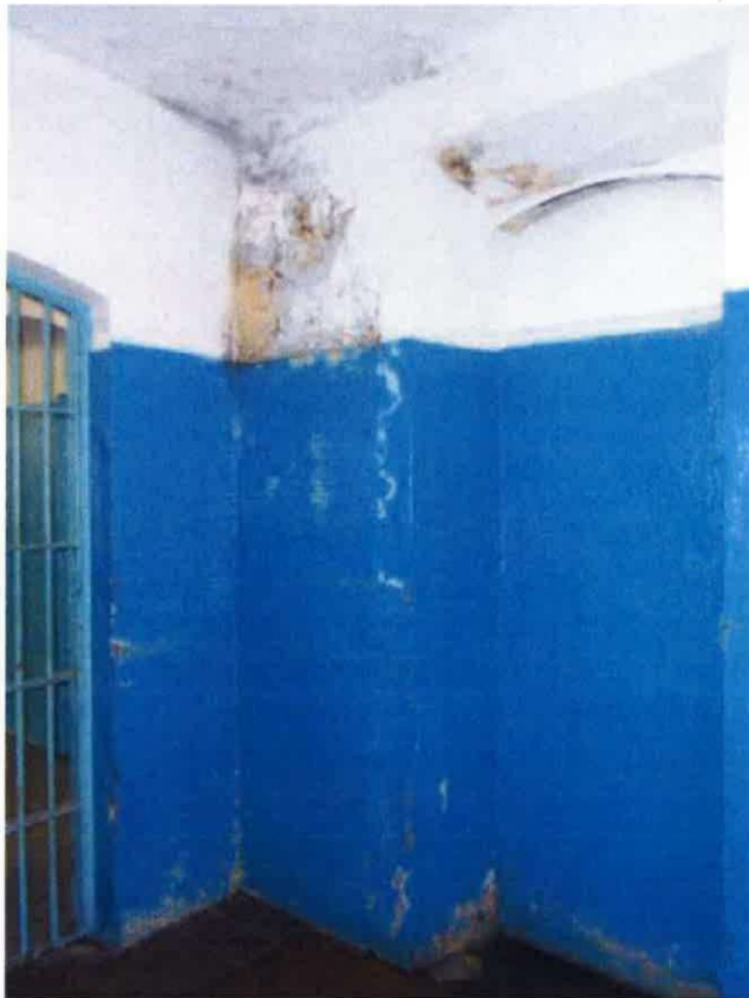
Paredes dos corredores do presídio
