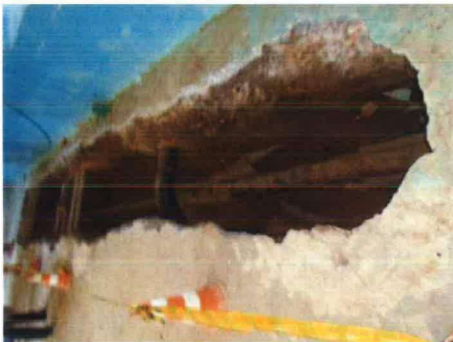
Obra Sabesp de troca de canos
