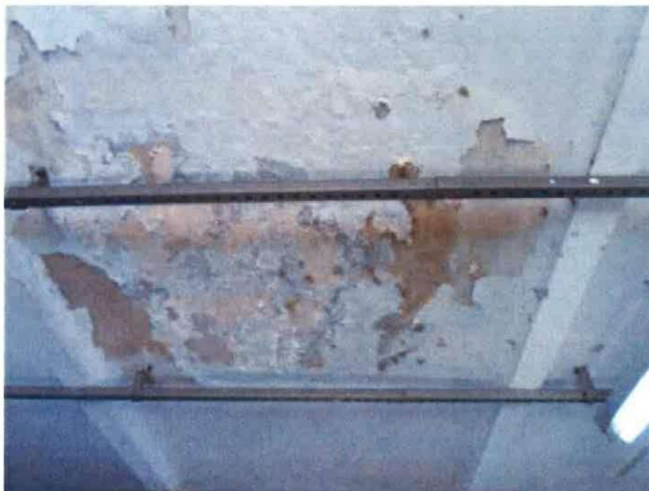
Teto do corredor
