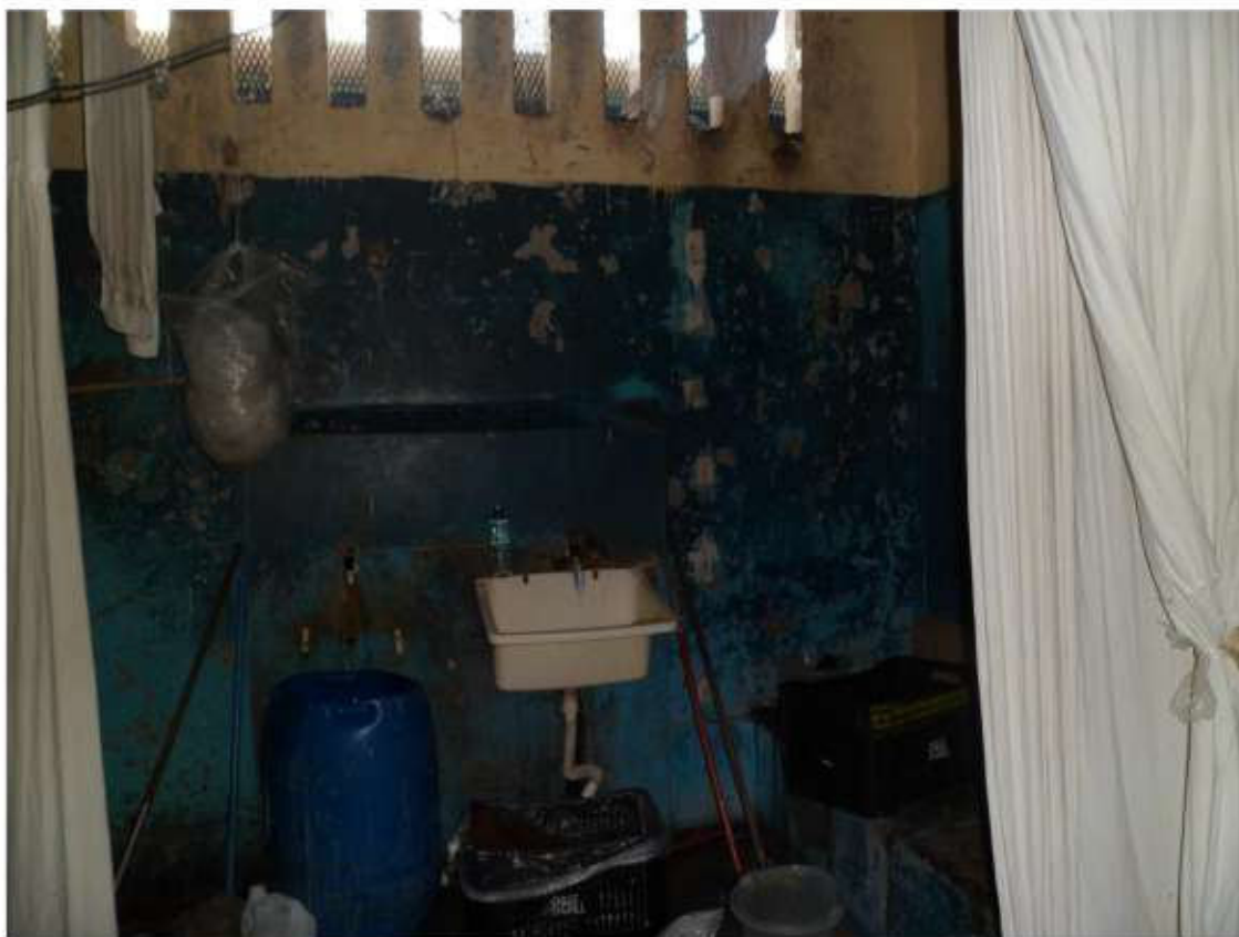
Banheiro da cela
