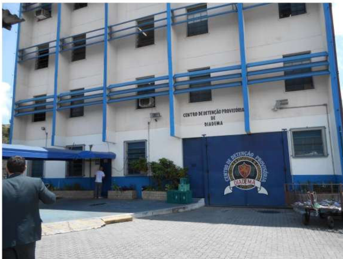
Área externa ao prédio do CDP que abriga os presos
