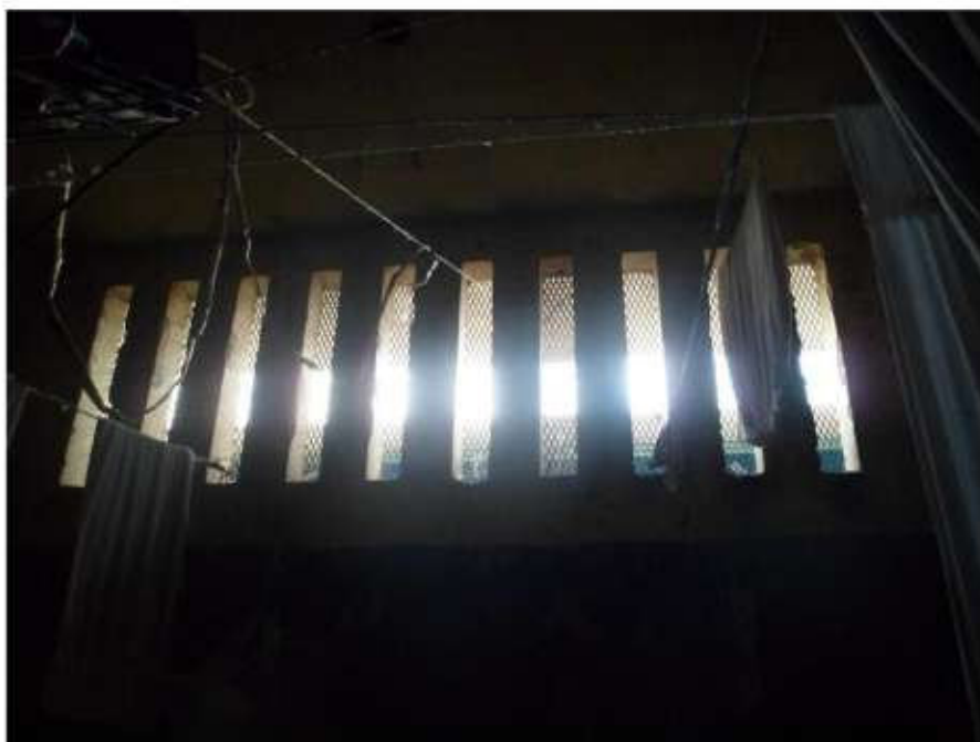
Fresta de entrada de ventilação e iluminação
