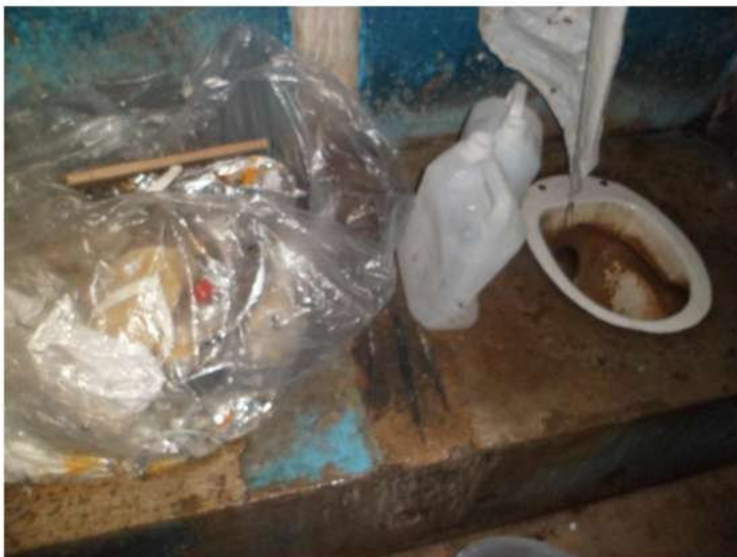
Situação precária do banheiro da cela
