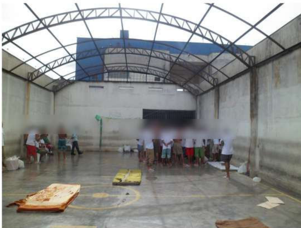
Quadra para banho de sol no terraço do prédio
