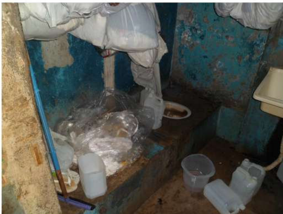
Situação precária do banheiro da cela com recipientes para acumular água
