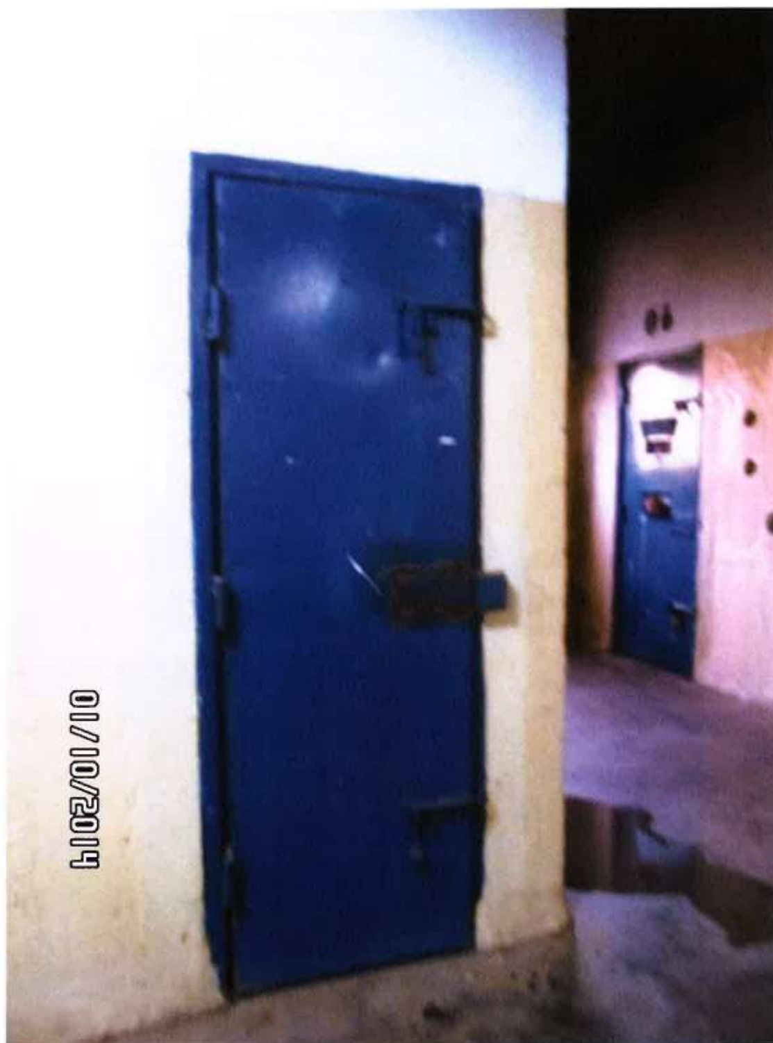
Solitária – Cella sem entrada de luminosidade que é fechada por uma porta chapada
