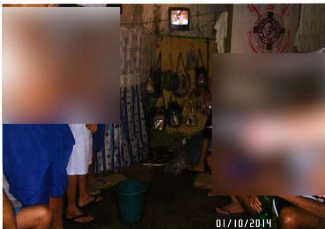
Cela superlotada do raio 2 - falta de ventilação, espaço e iluminação
