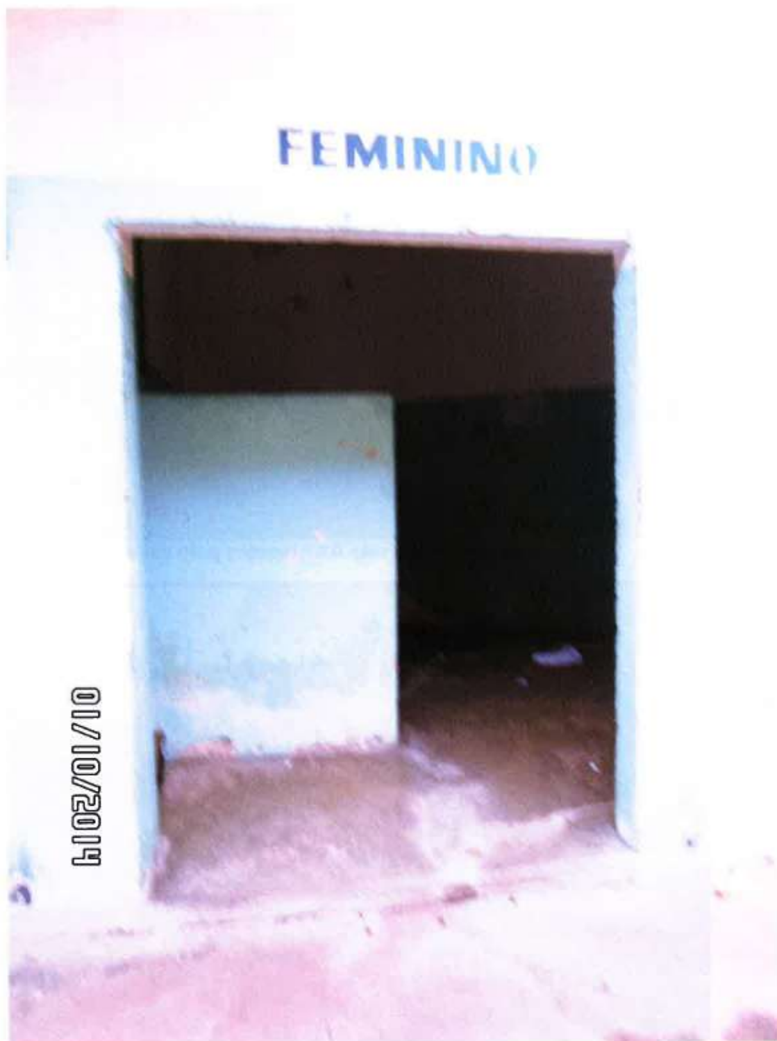
Banheiro do raio 02 usado pelas visitantes
