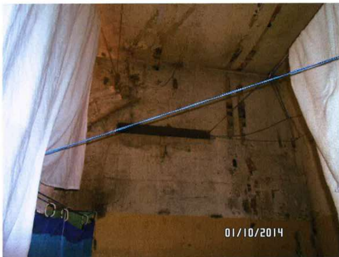
Cela do raio 2 - único espaço destinado à iluminação da cela encontra-se fechado
