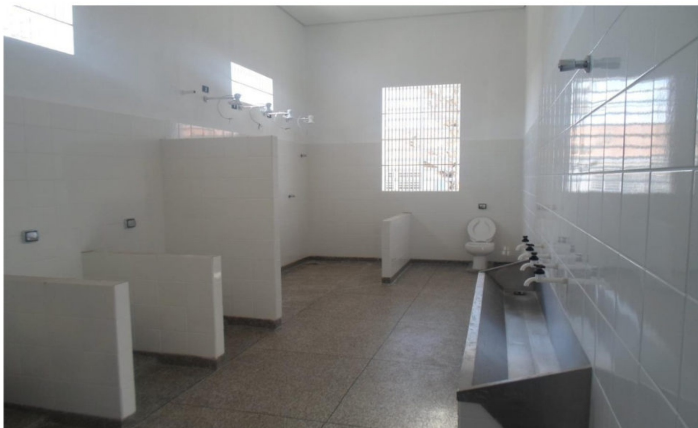
Figura 19 - Banheiro novo pavilhão (em reforma)
