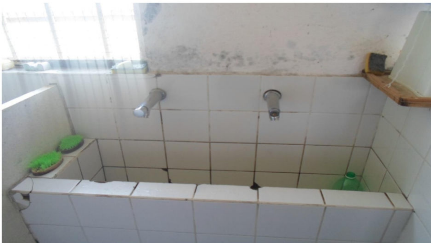
Figura 13 - Banheiro da ala masculina
