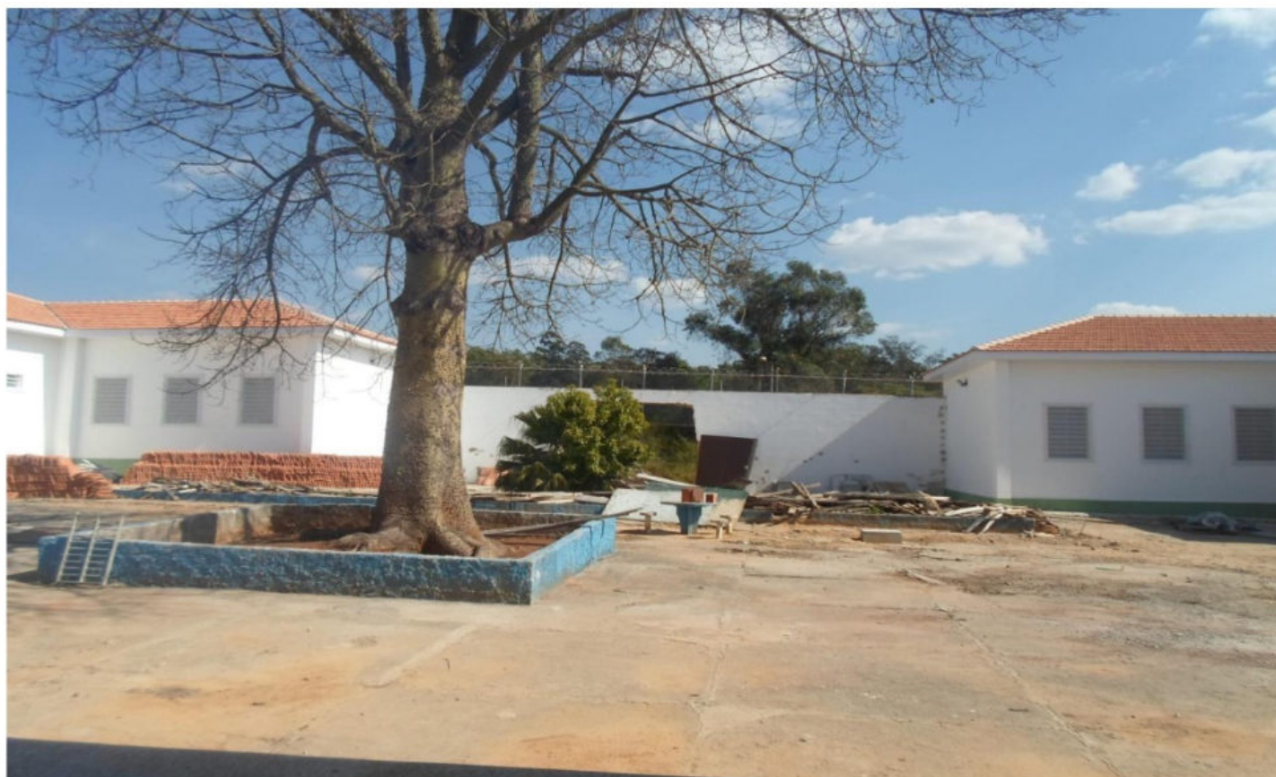
Figura 21 - Novos pavilhões (em reforma)
