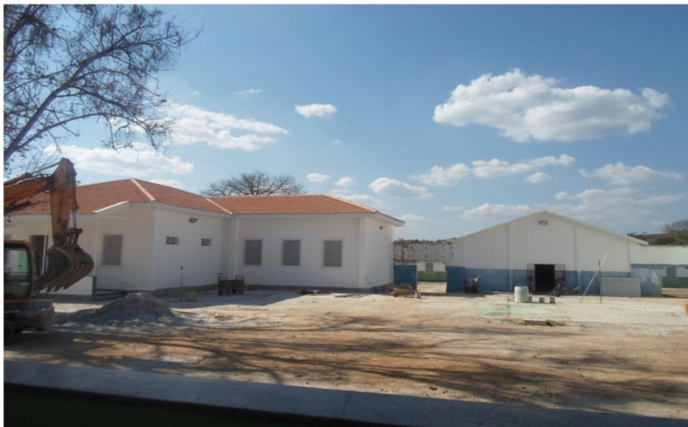
Figura 20 – Novos pavilhões (em reforma)
