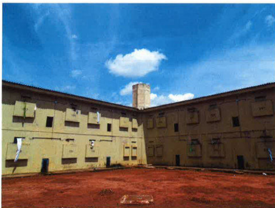
Imagem 2: Visão externa do pavilhão 04 (em reforma)
