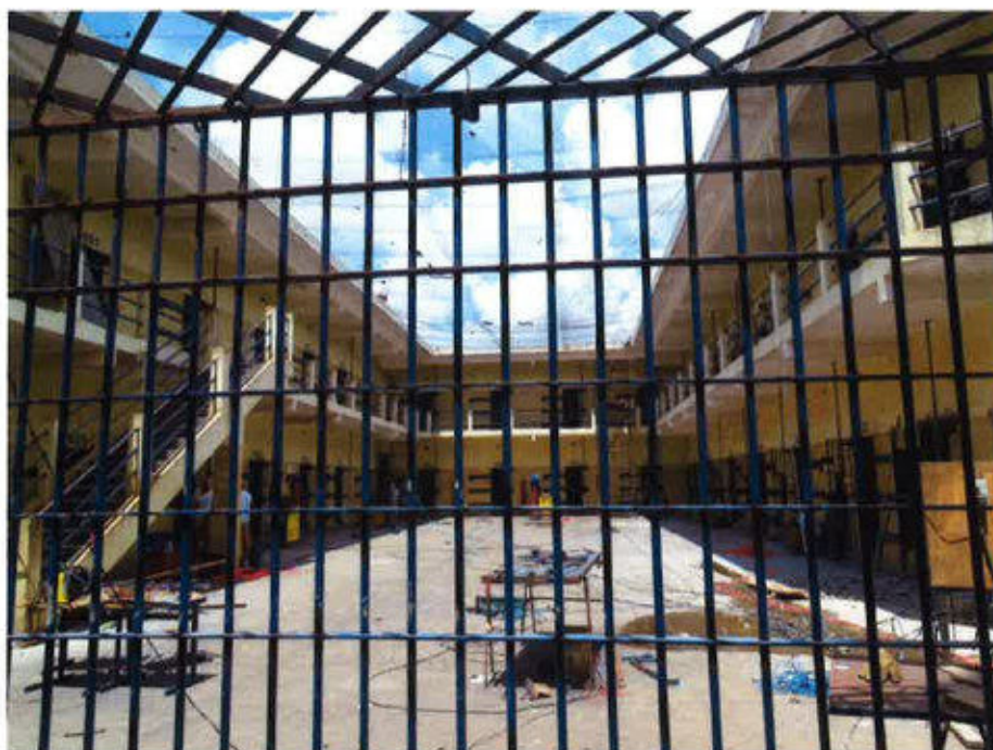
Imagens 3 e 4: Visão interna do pavilhão 4 (em reforma)
