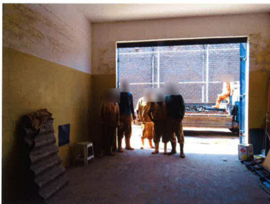
Imagens 6 e 7: presos trabalhando na reforma do pavilhão 4
