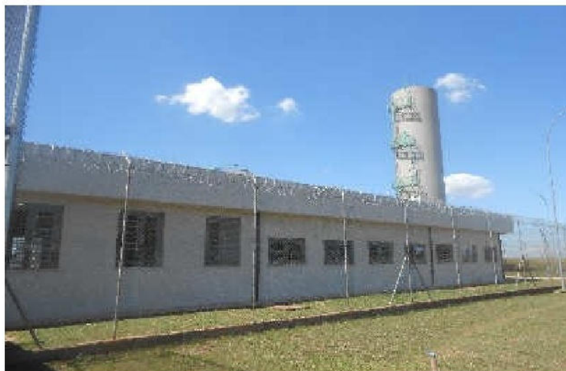
(Visão externa da ala de progressão da Penitenciária – lado direito)
