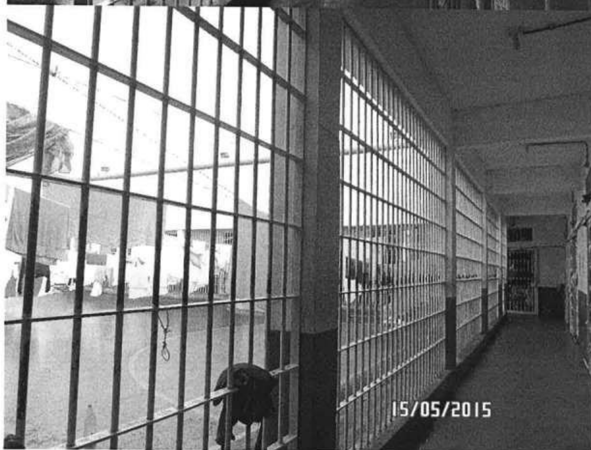
Ala do convívio – Há um pátio no meio e as celas em volta. Há um corredor que separa o pátio e as celas.
