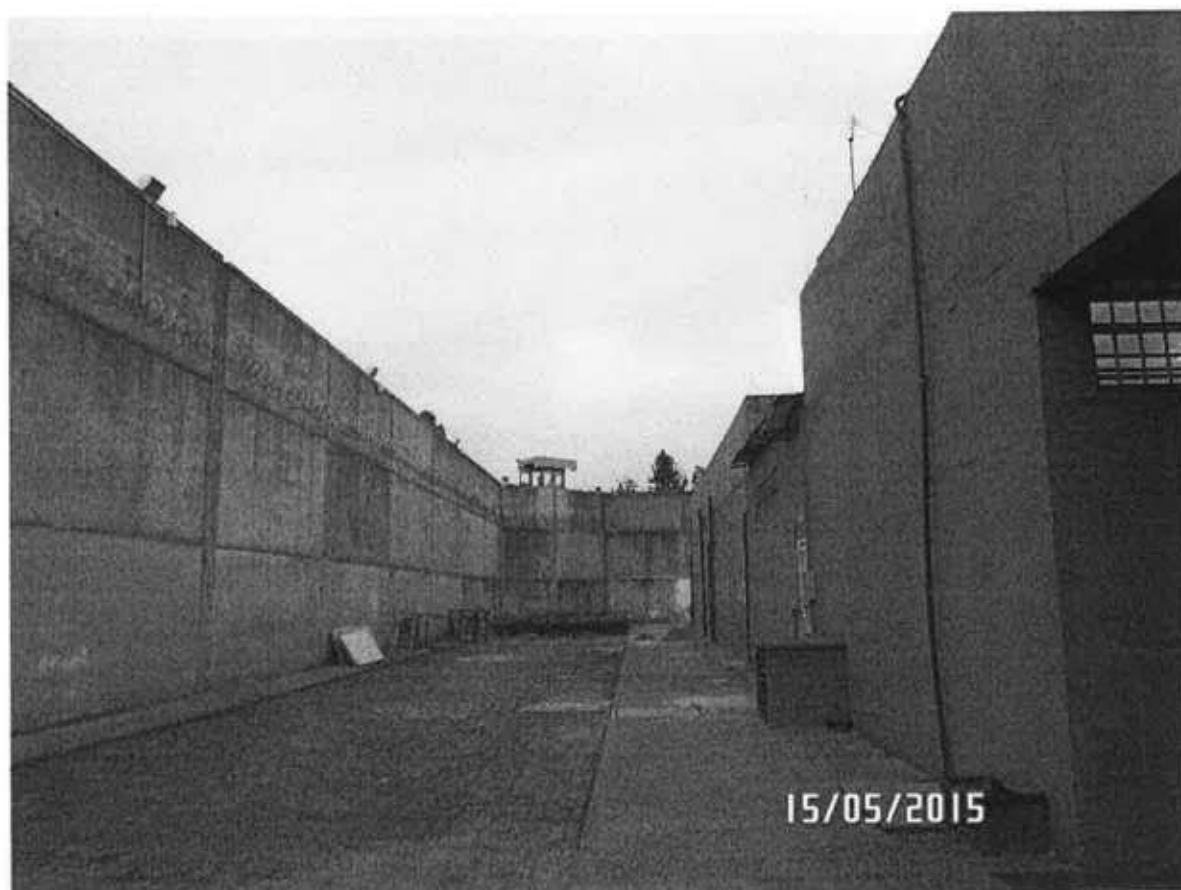
Área aberta entre o prédio administrativo da unidade e os pavilhões
