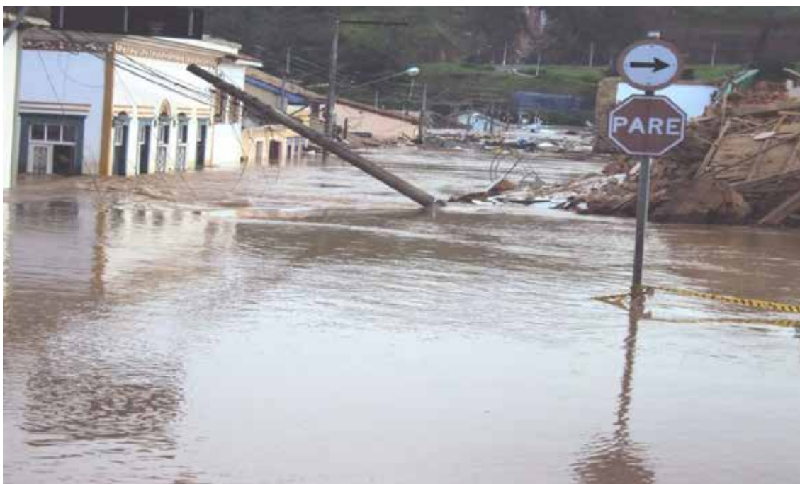
Alagamento e destruição do centro histórico da cidade.
