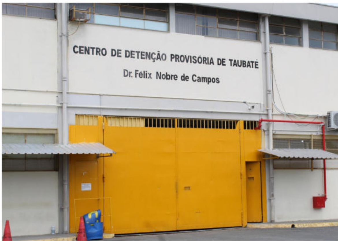
(detalhe da fachada na unidade inspecionada)
