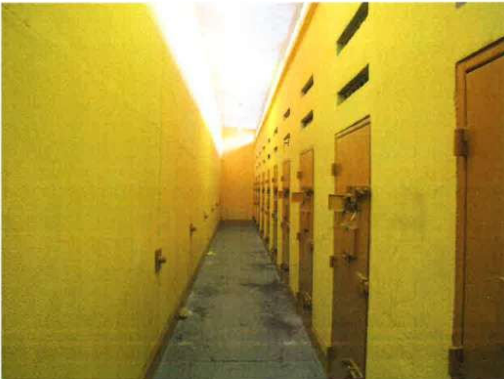
Foto 4 – Corredor das celas do Setor de Disciplina
