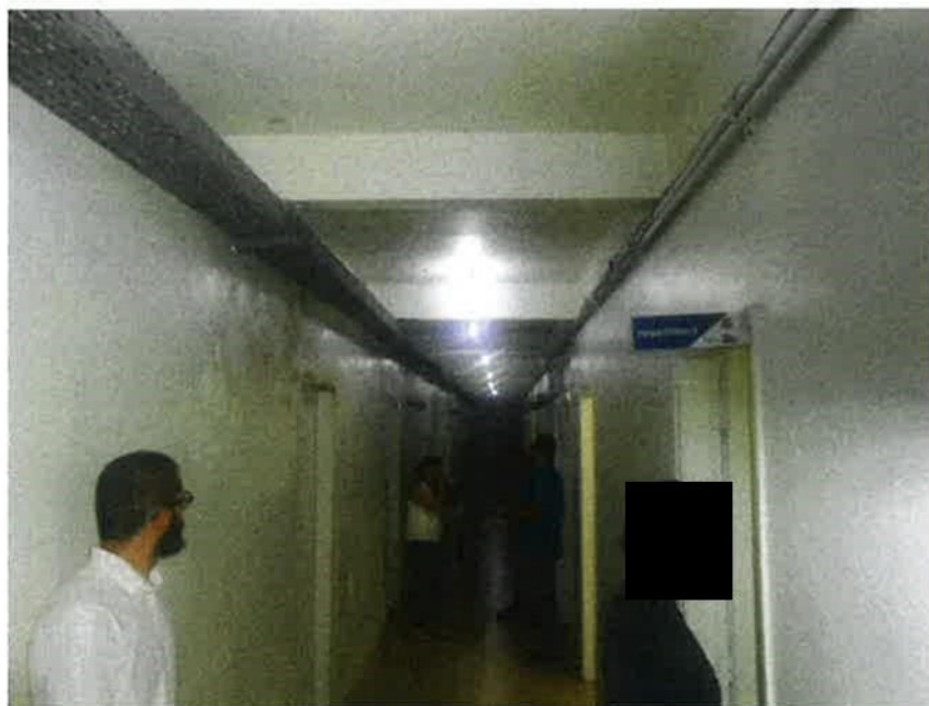
Corredor do setor de enfermagem (consultórios e dispensário)
