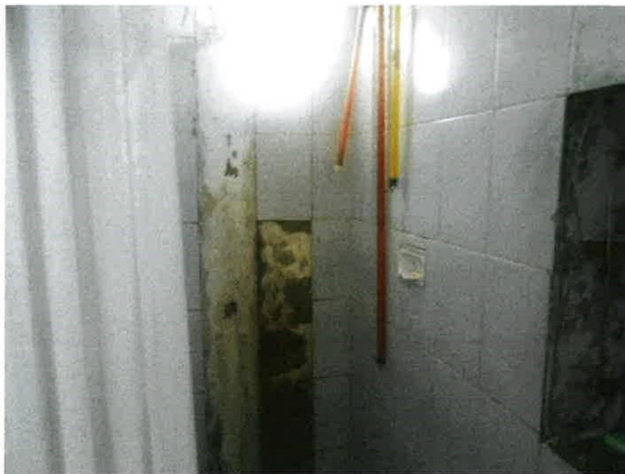
Detalhe do banheiro
