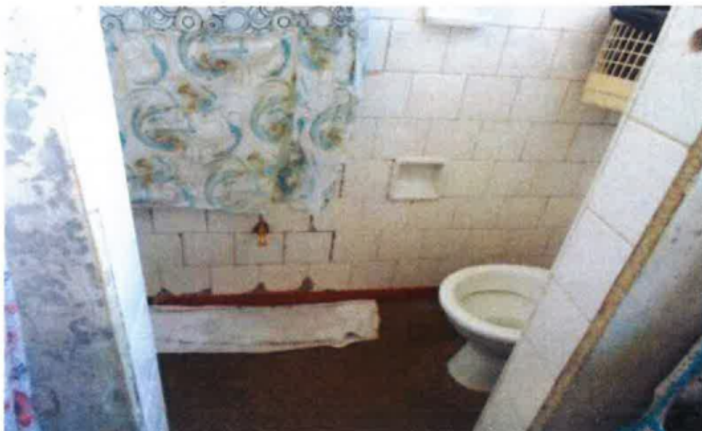
Figura 7 - banheiro das celas
