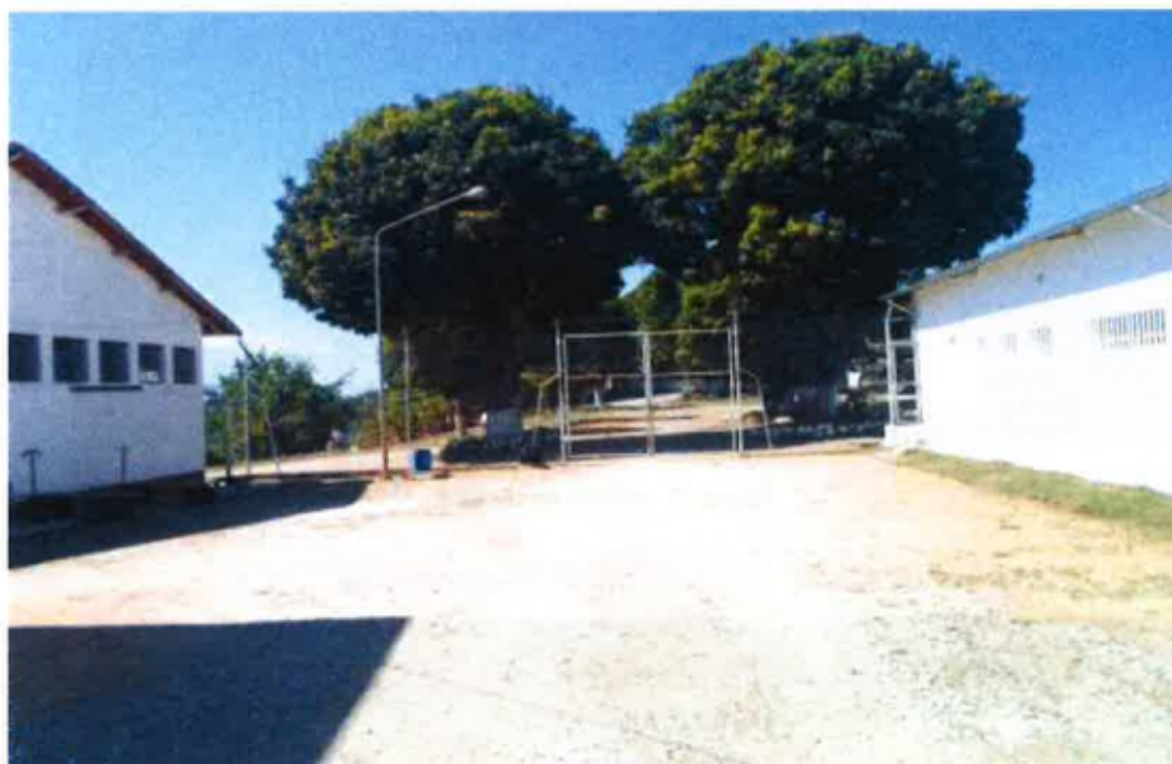
Figura 15 - acesso ao semiaberto e oficinas
