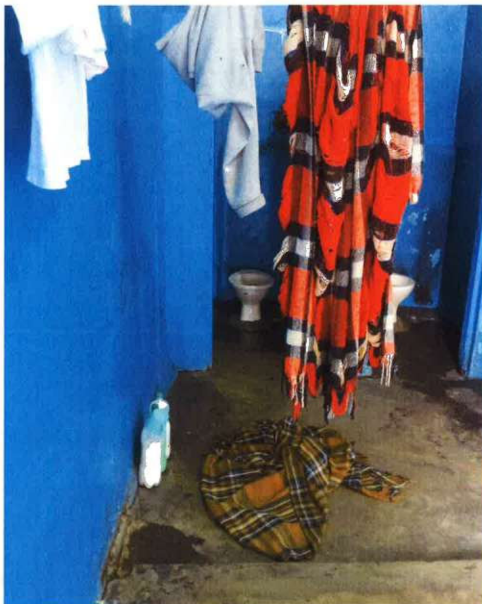
5 – Infraestrutura da unidade prisional
