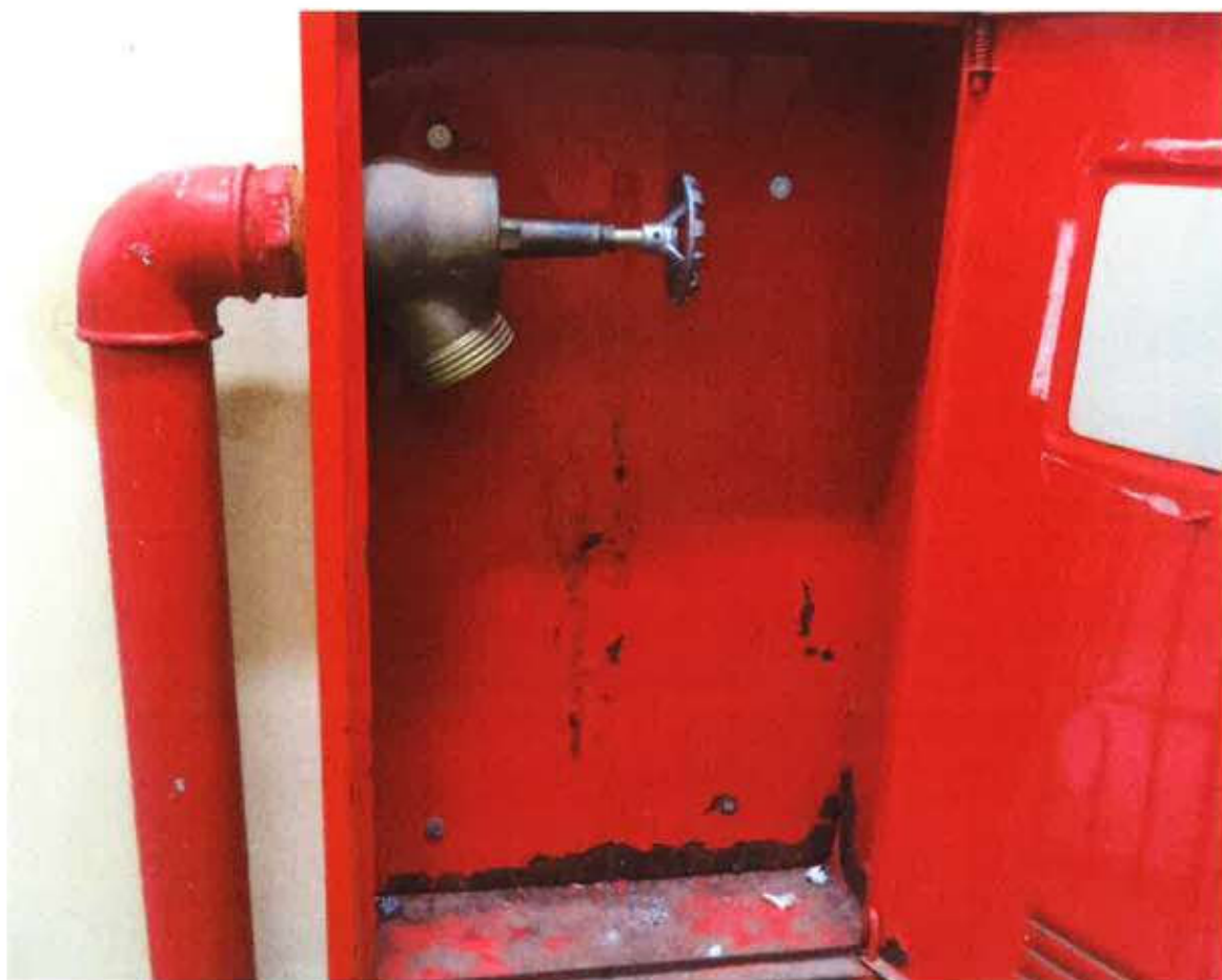
7 – Infraestrutura da unidade prisional
