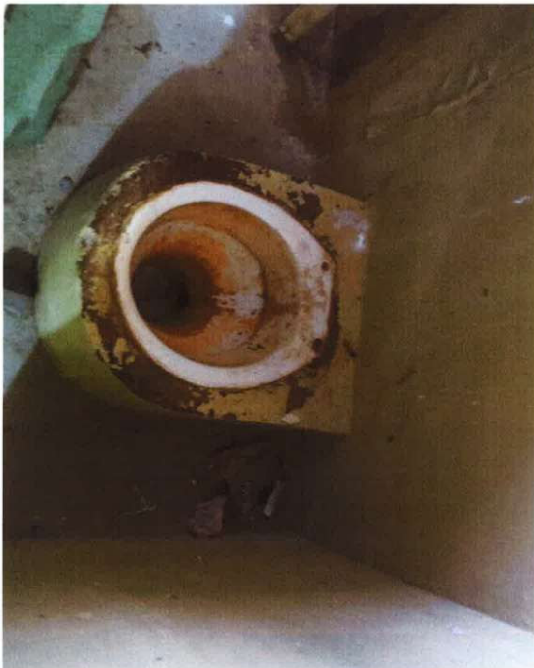
6 - Infraestrutura da unidade prisional
