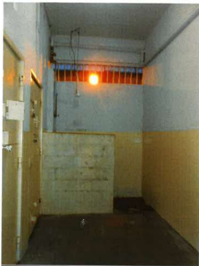
Corredor em frente às celas da enfermaria e chuveiro externo às celas.
