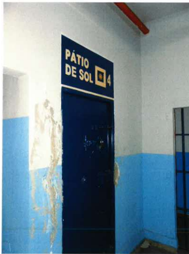
Porta de acesso ao pátio para banho de sol.
