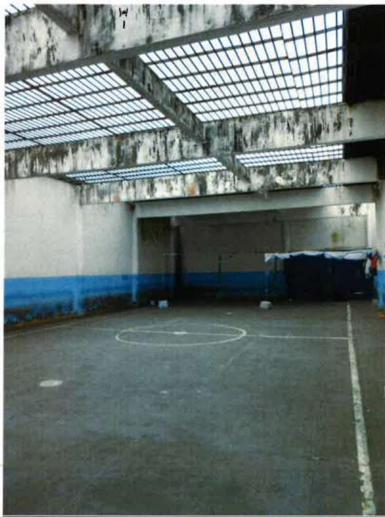
Pátio para o banho de sol, localizado na cobertura do prédio.
