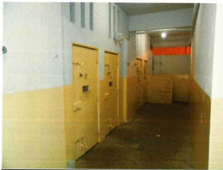
Corredor em frente às celas da enfermaria.
