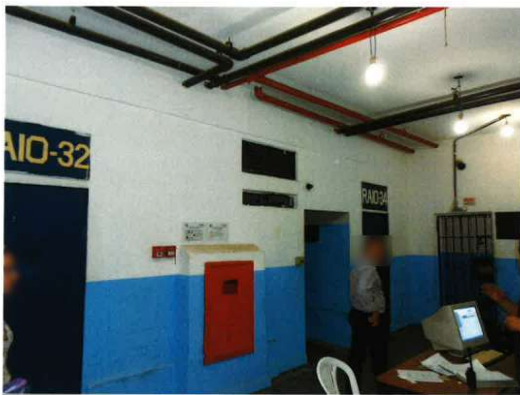
Visão das portas dos raios.
