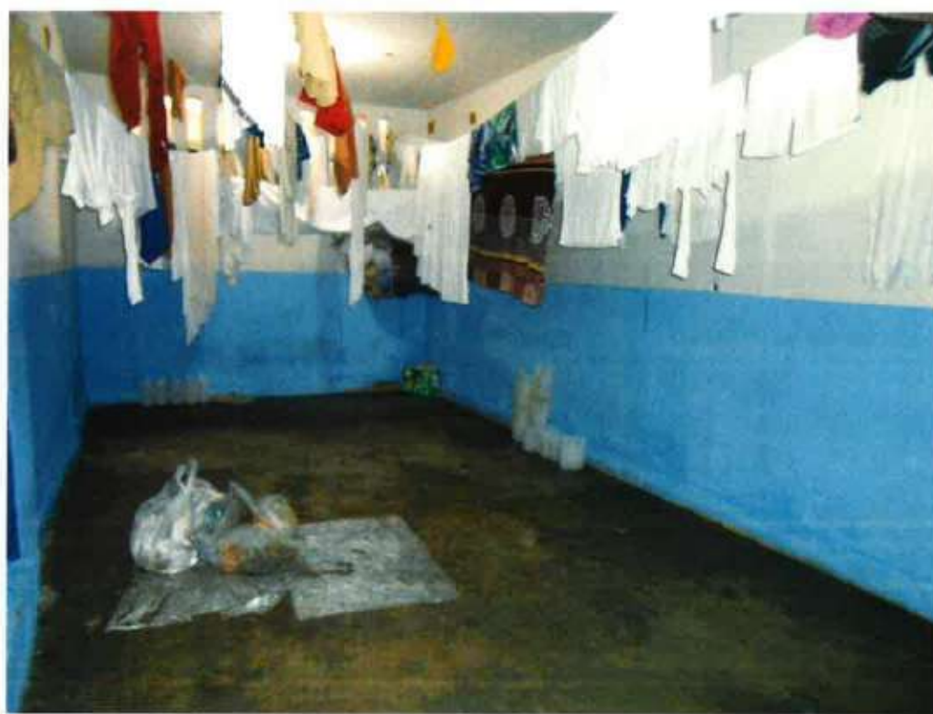
Pátio interno no setor do convívio, localizado ao lado das celas.
