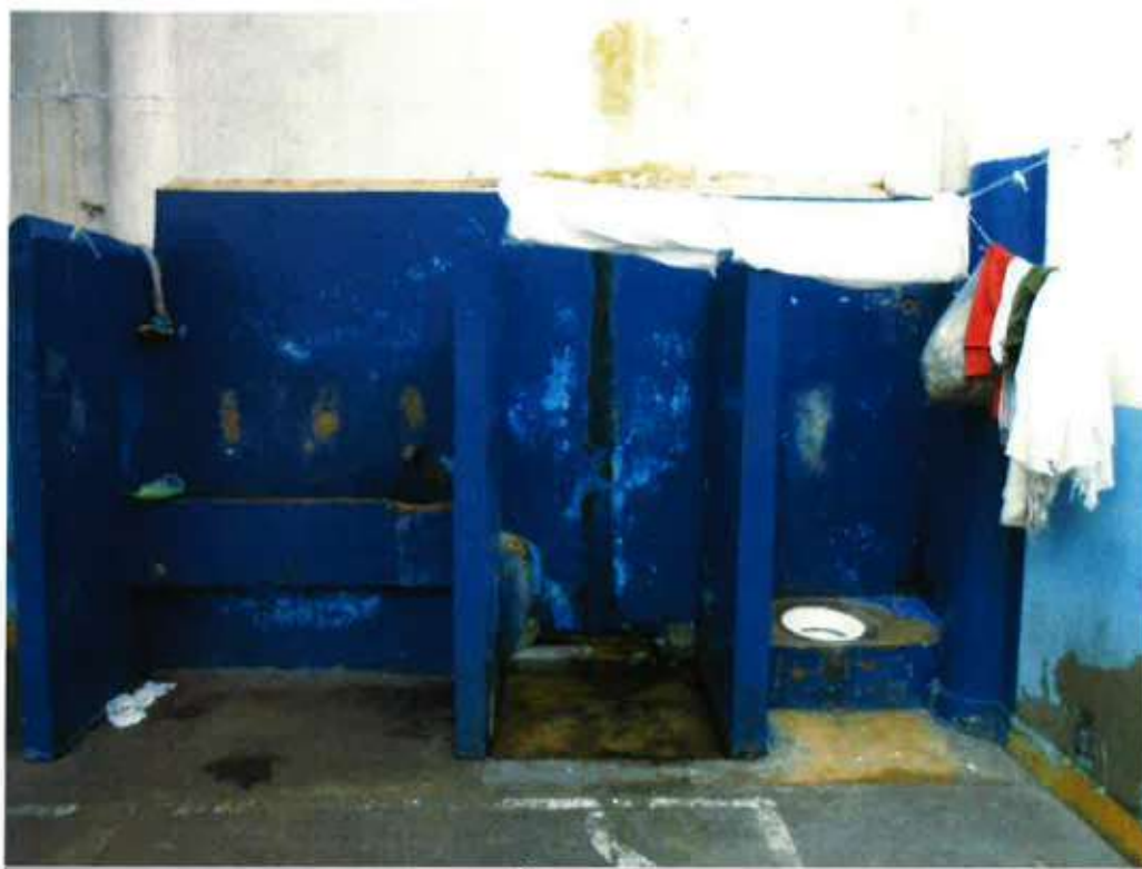
Sanitário na área externa do pátio.
