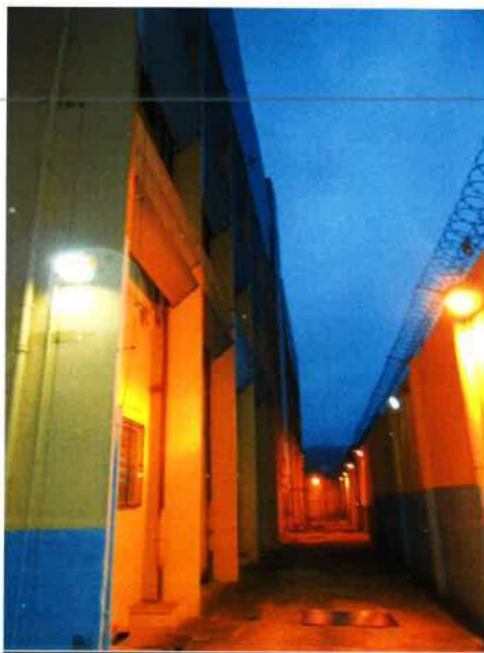
Outra foto da lateral do prédio.
