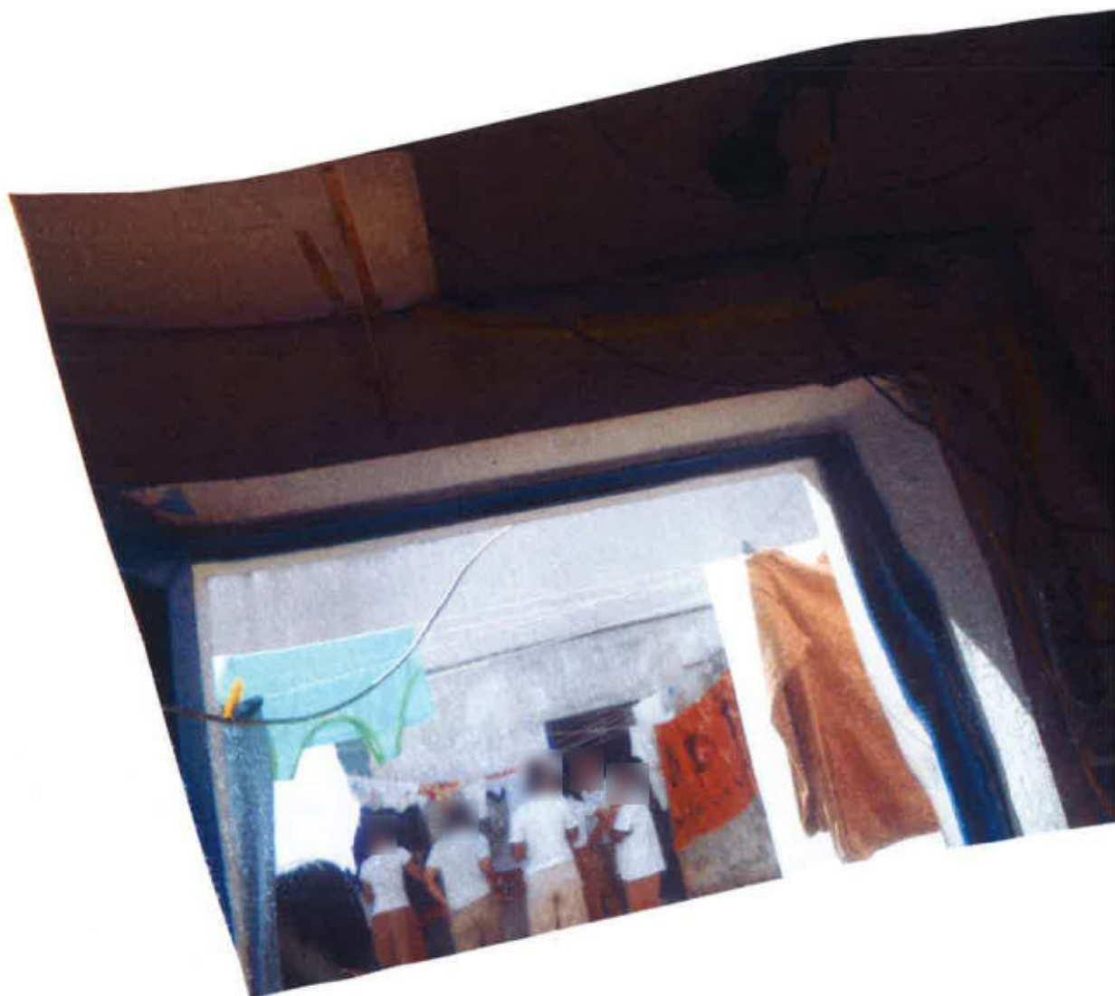
Fiação exposta nas celas
