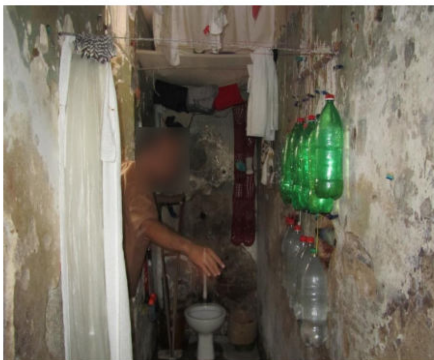
Banheiros do regime fechado.
