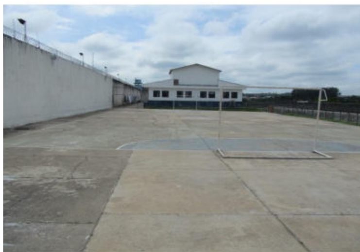
Vista do alojamento do regime semiaberto.
