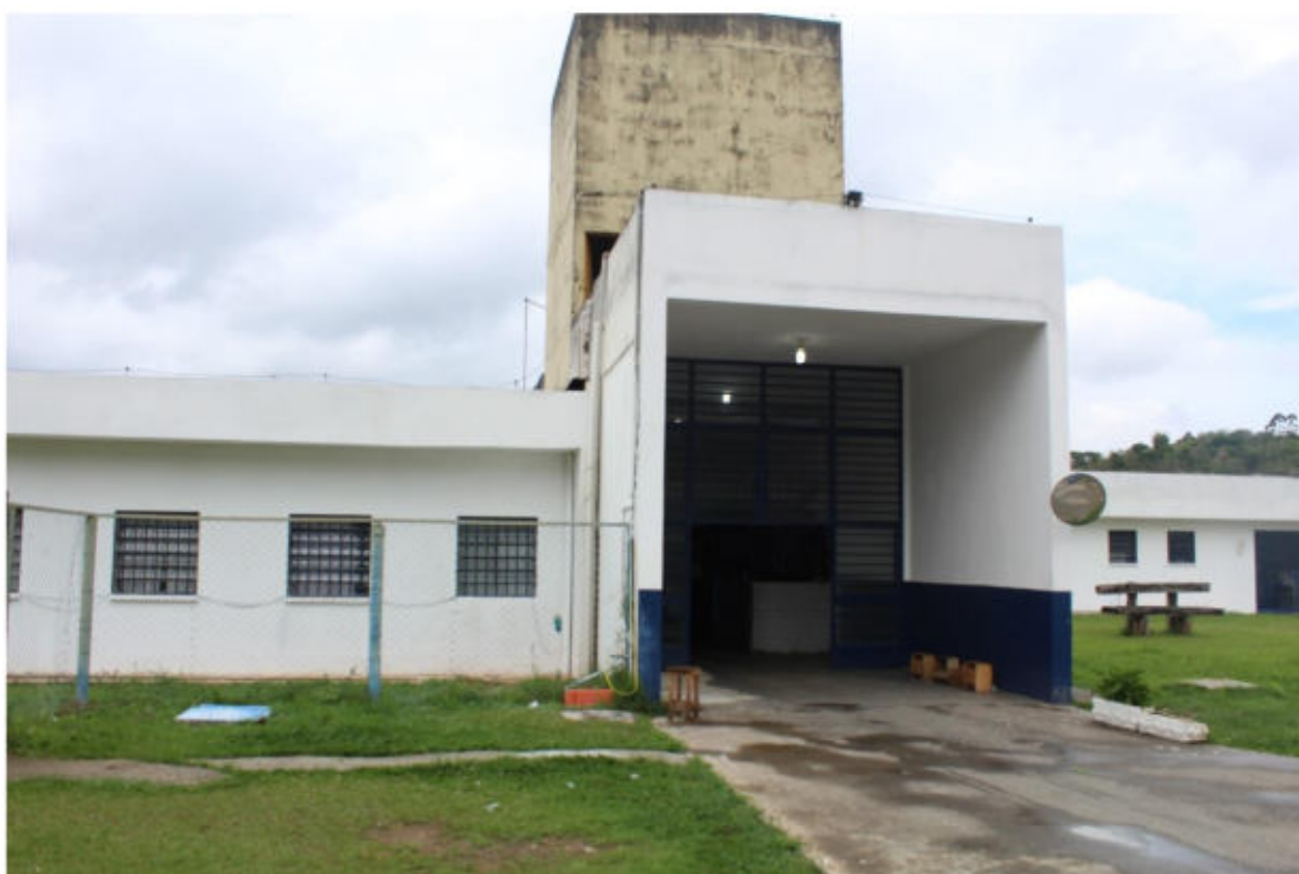
(Área de acesso aos pavilhões)
