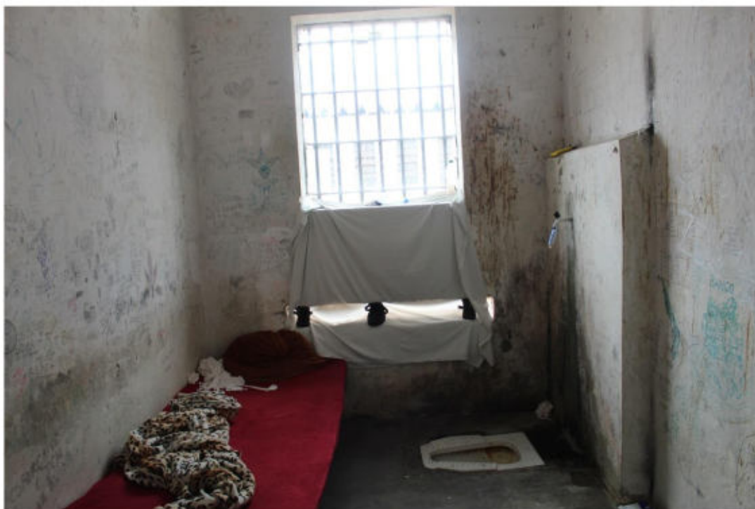
(interior de celas do setor disciplinar – sem chuveiro, sem descarga)
