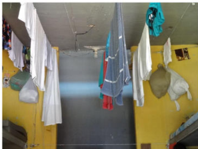
Iluminação da claraboia existente na parte do banheiro interno (dentro da cela)
