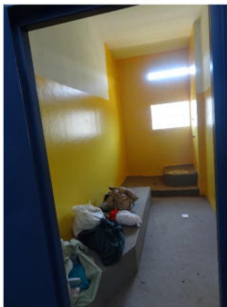
Detalhe para as janelas e iluminação
