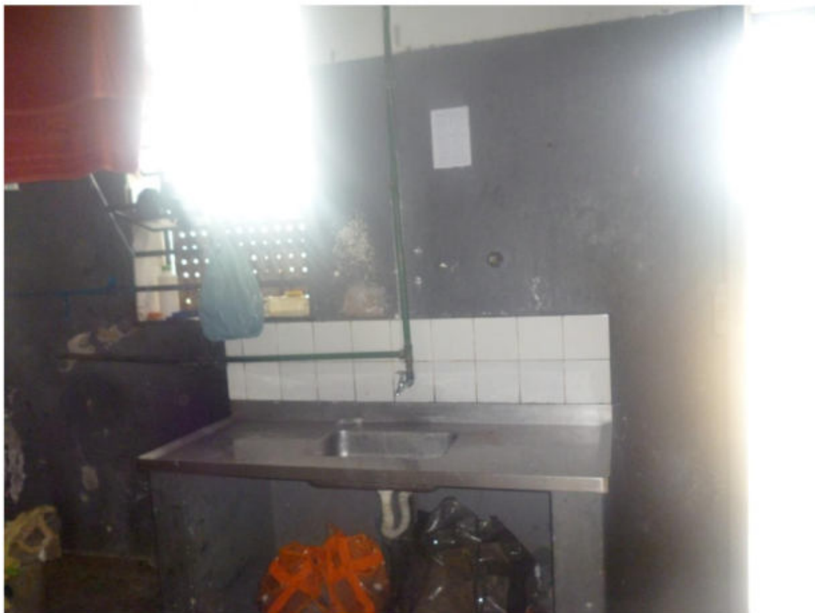
Área comum e refeitório habitacional
