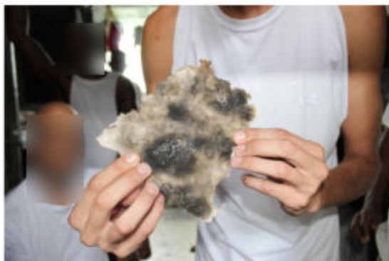
Pedaço de mofo da parede
