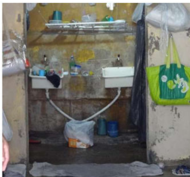
(pia aguardando água para a limpeza)
