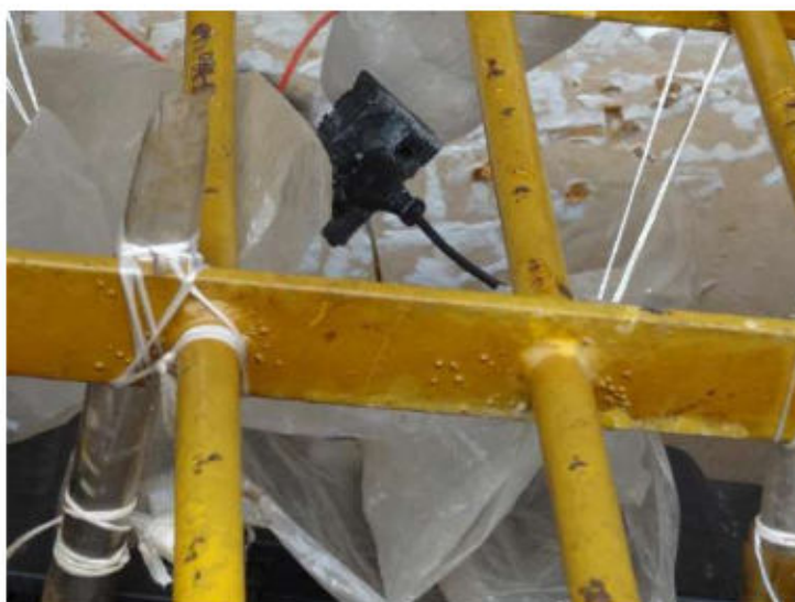
(estrutura de garrafa pet para evitar vazamento de água)
