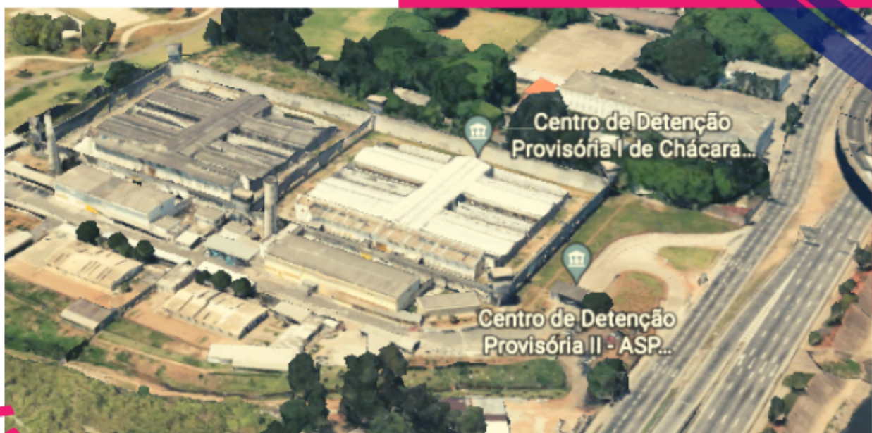
CDP Belém II - unidade compacta
