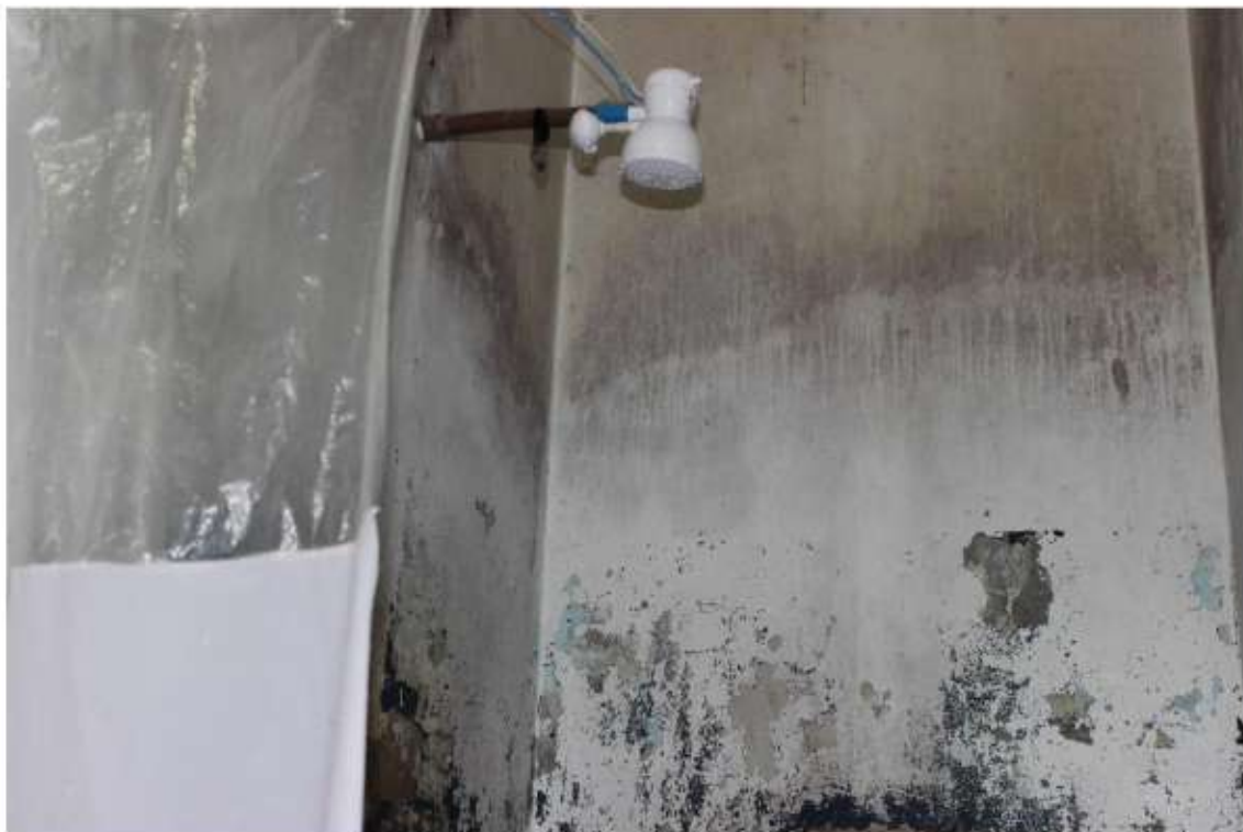
(chuveiros elétricos instalados em toda unidade)
