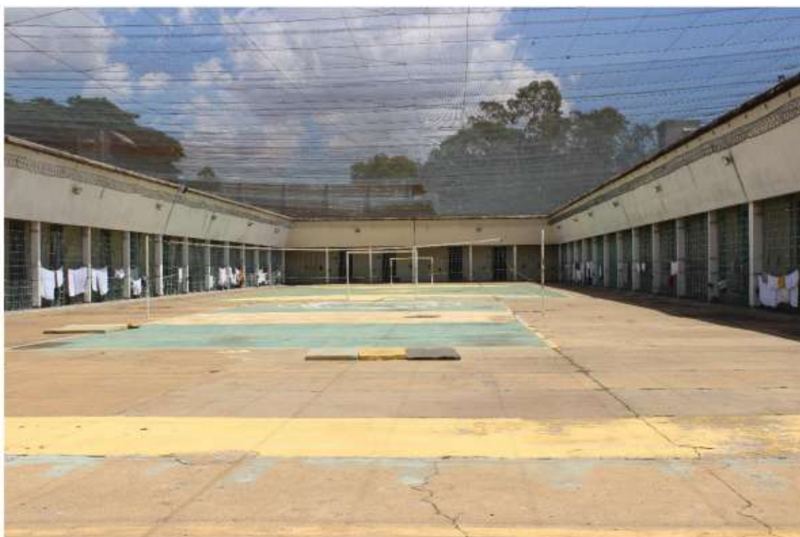
(vista frontal do pavilhão de convívio)
