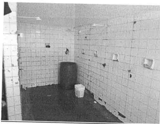
Foto 13: banheiro coletivo, chuveiros.
