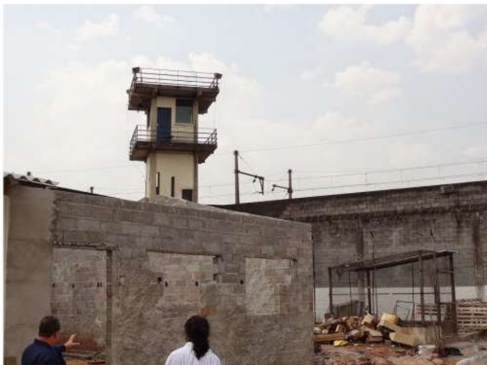
Setor de educação (escola) em construção – obras ainda em estágio inicial
