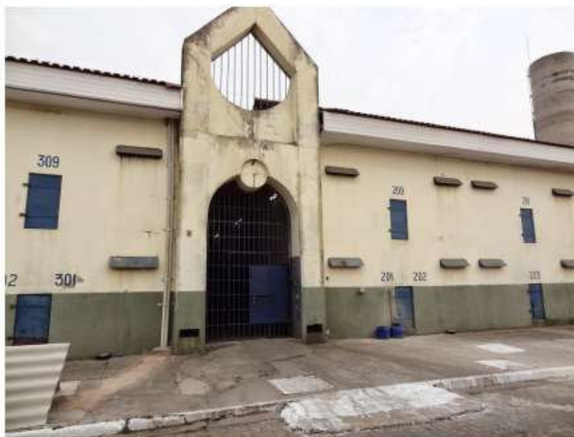
Portão de entrada para os setores de aprisionamento (pavilhões habitacionais, RO e “seguro”)
