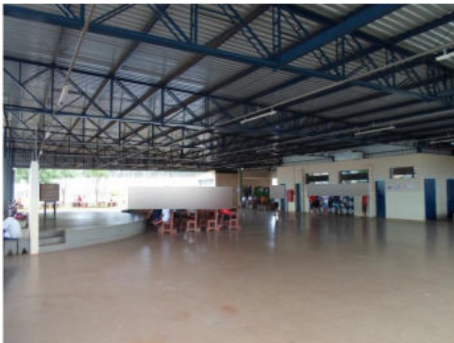
Área de convívio. Há uma TV instalada no local.
