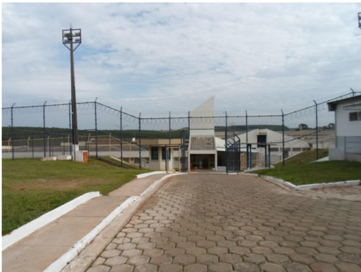
Figura 23. Entrada da Unidade.
