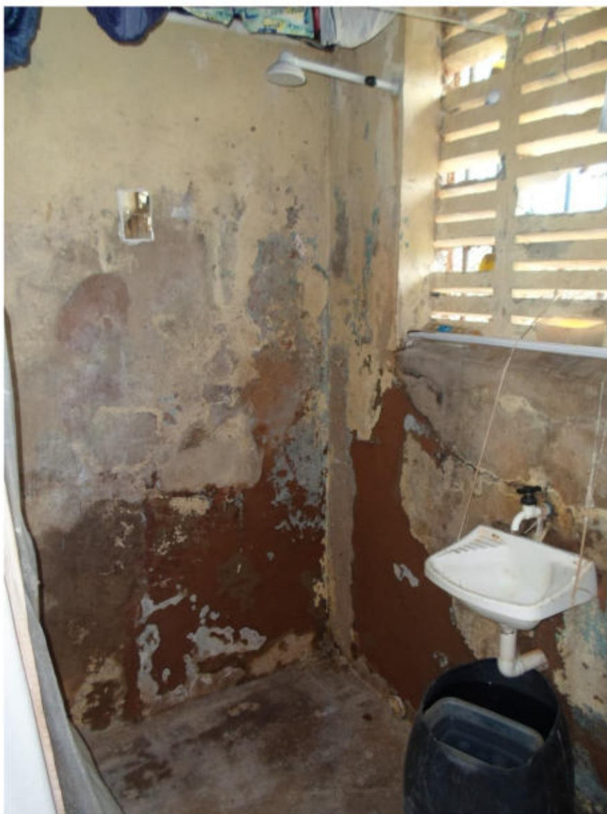
Figura 5. Banheiro da cela do convívio
