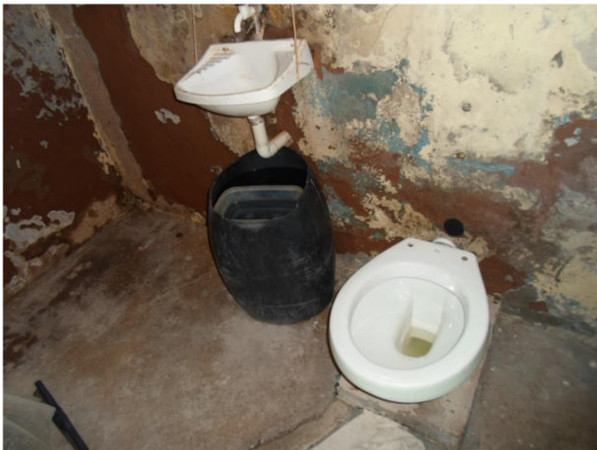
Figura 2. Banheiro da cela do convívio
