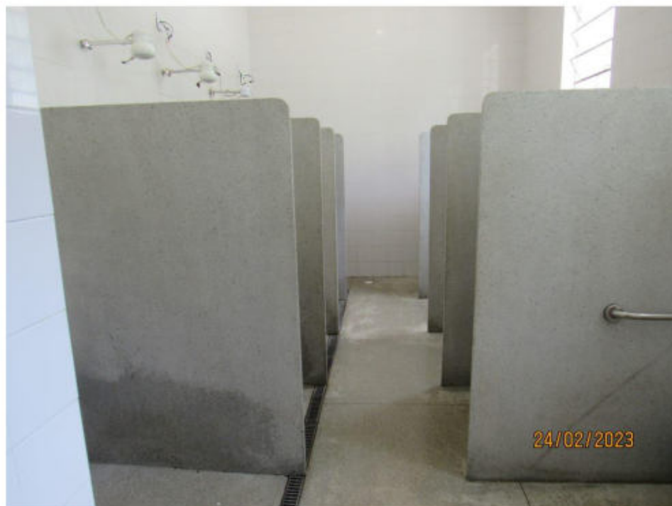
fotos dos banheiros de um das enfermarias
