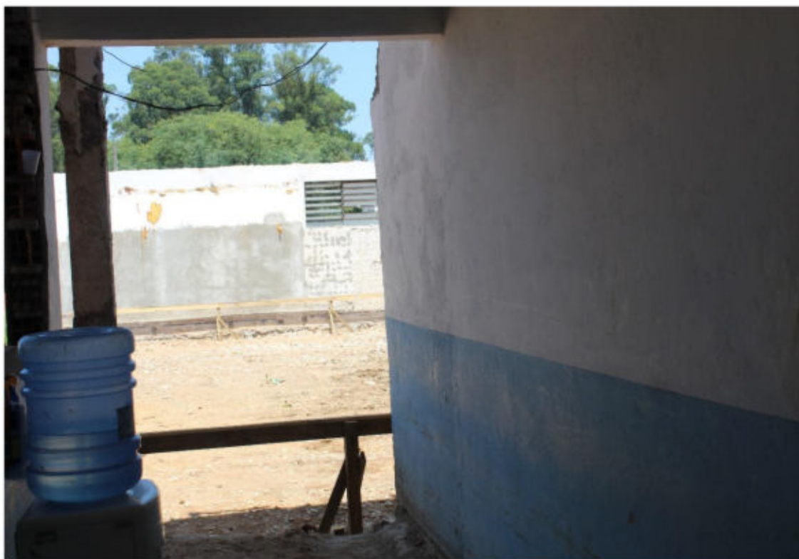
Obras da cozinha
