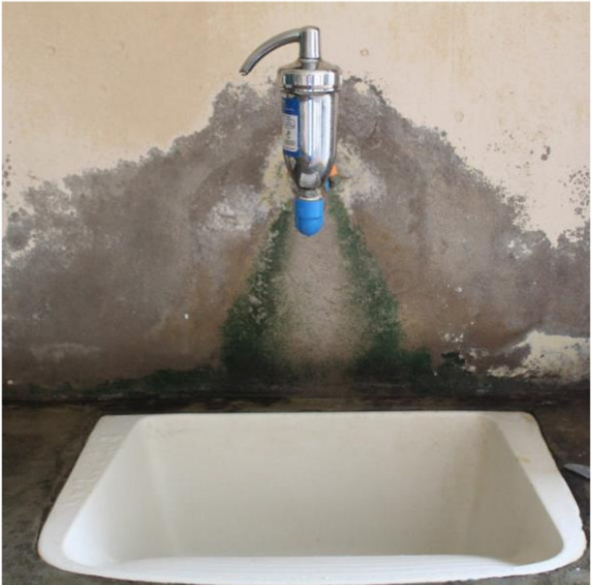
Filtro de água instalado na pia de uso comum do raio
