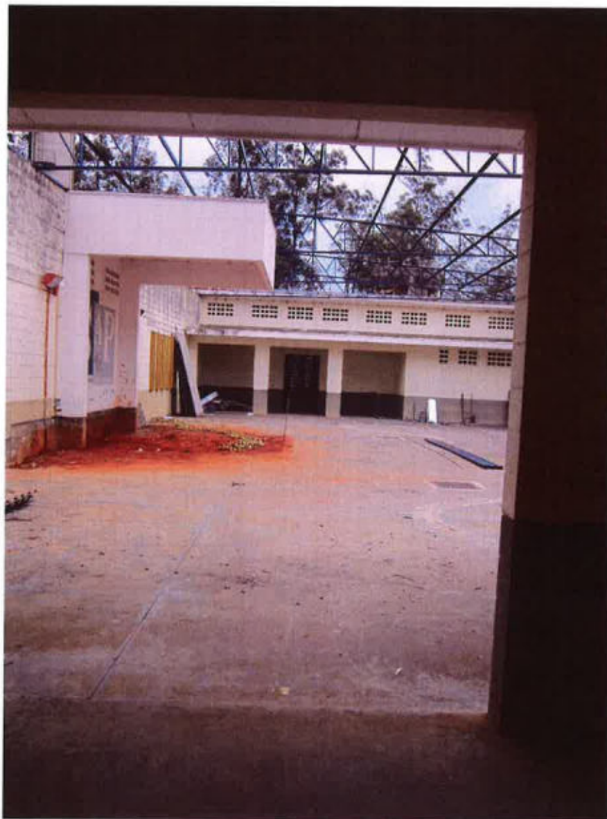
Foto 7: pátio em reformas para instalação de nova empresa
