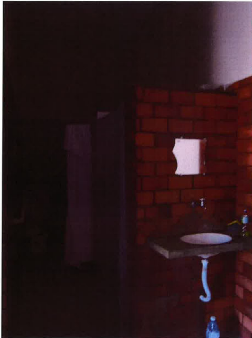
Foto 8: banheiro de uma das celas especiais
