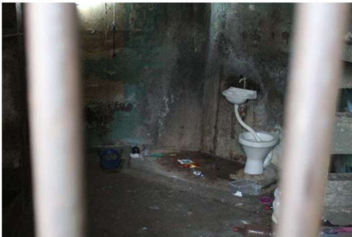
(Pia com sifão desinstalado no Pavilhão)
