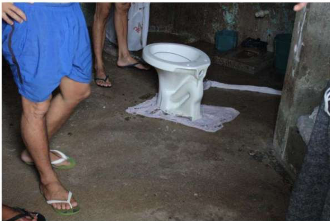
(Vaso sanitário desinstalado)
