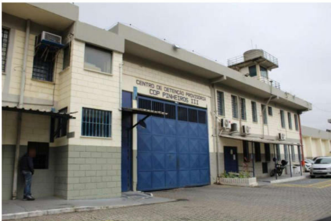
(fachada da unidade)
