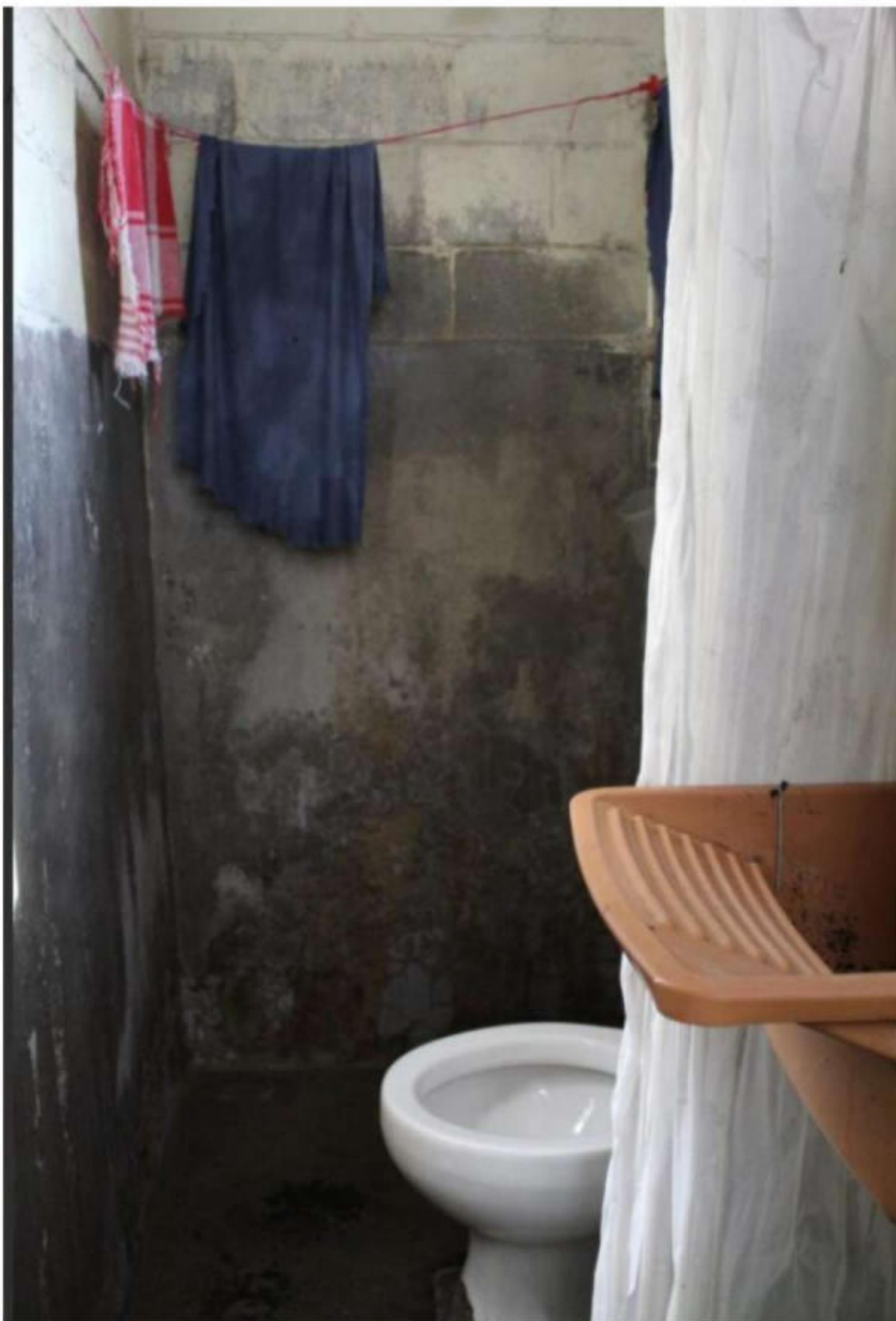
(banheiro de uma das celas)
