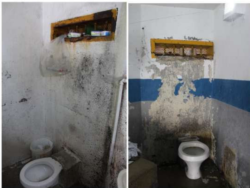
Detalhe de banheiros do interior de uma cela
