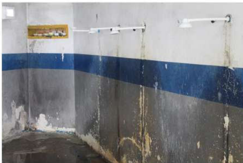
Local da instalação dos chuveiros quentes na área comum (o virado para cima não estava em funcionamento)
