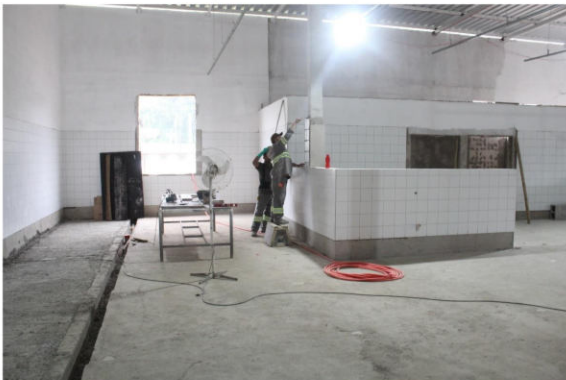
(Cozinha em reforma)
