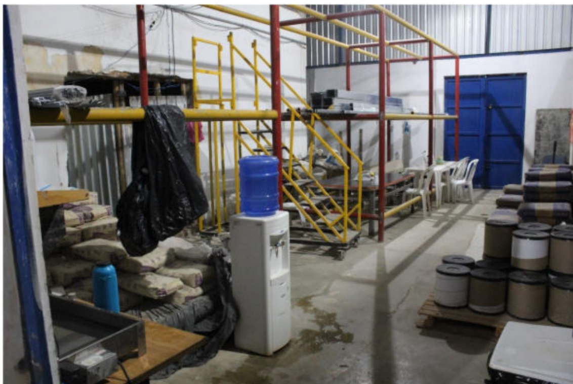
(Cozinha em reforma)
