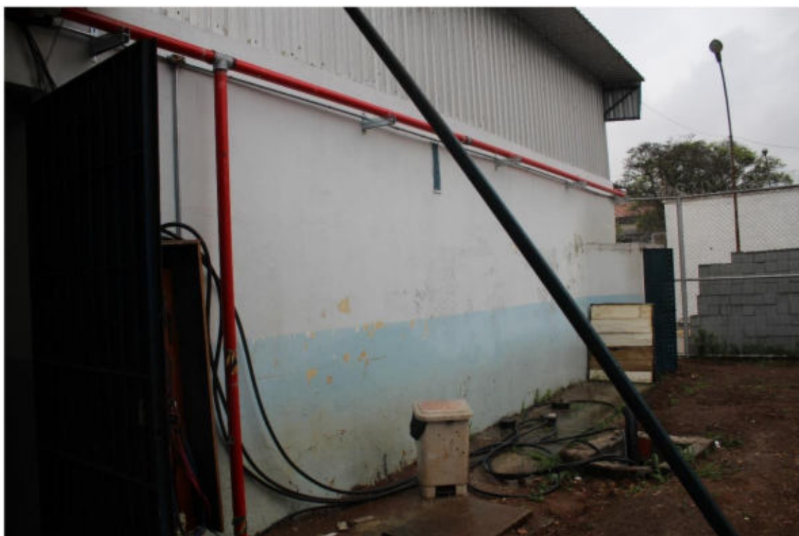
(Realização de reformas para a obtenção de AVCB)
