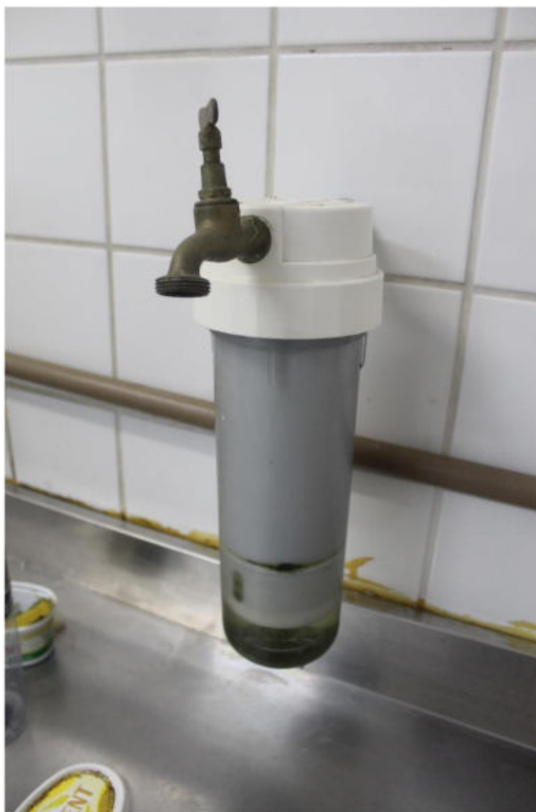
(Filtro sem condições de uso)
