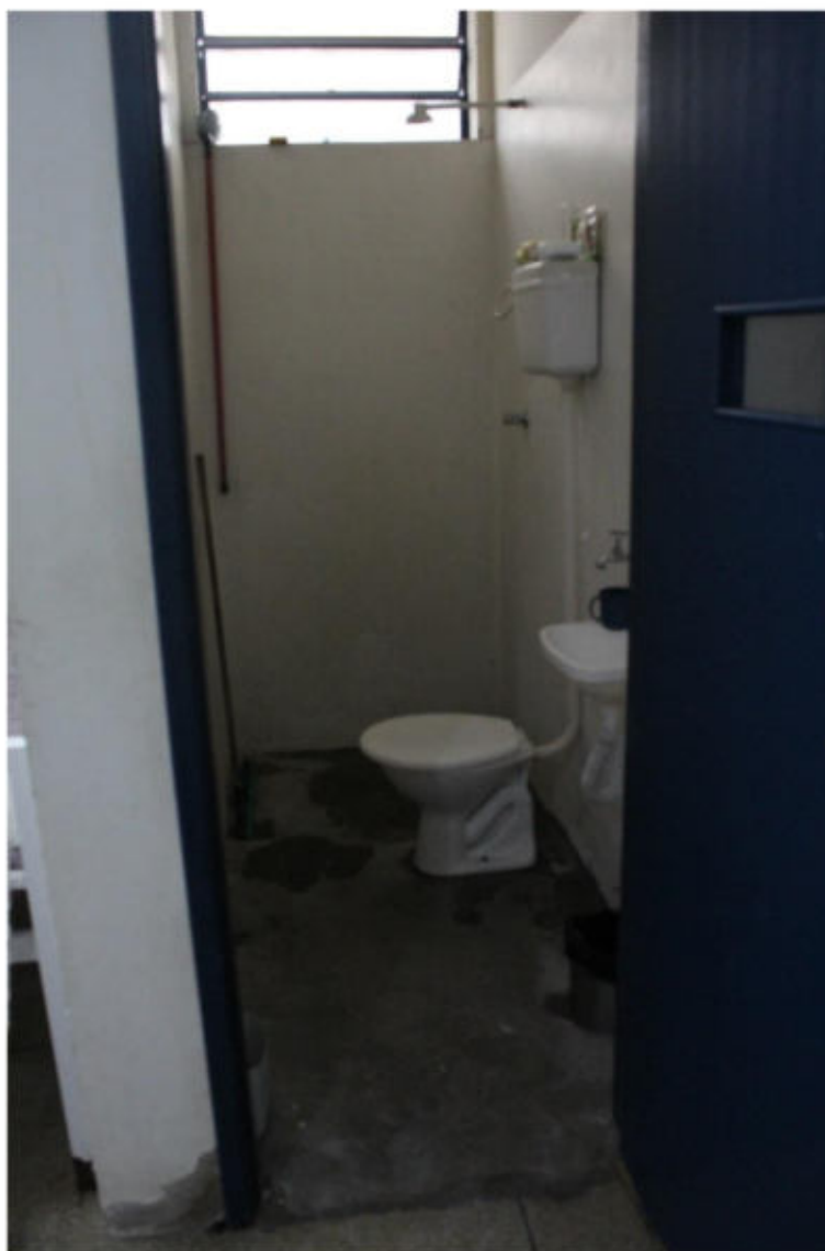
(Banheiro de cela da ala materno-infantil)
