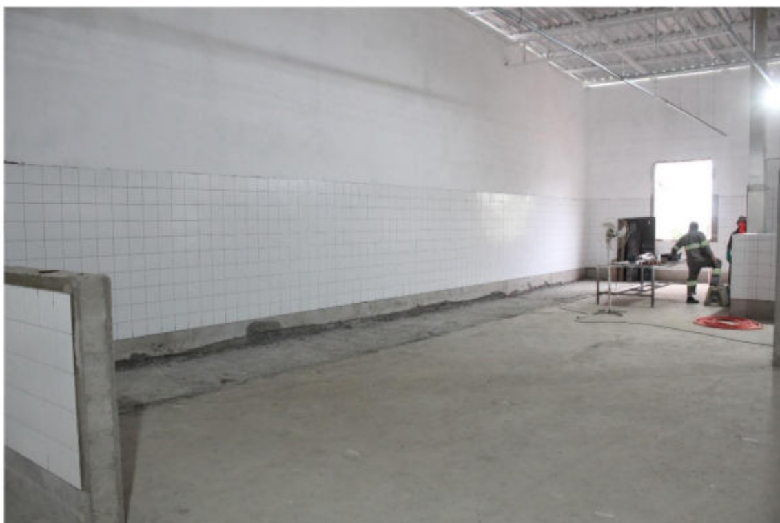
(Cozinha em reforma)
