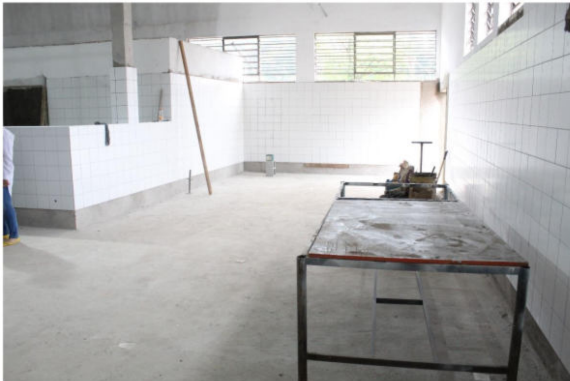
(Cozinha em reforma)
