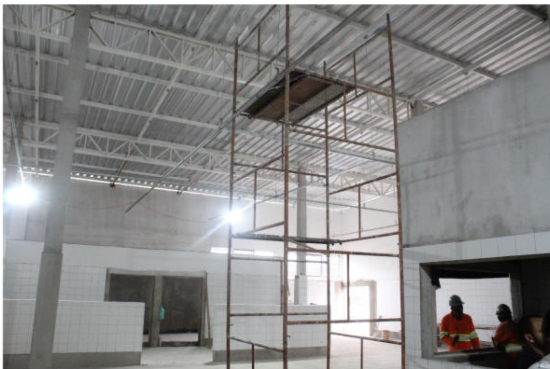
(Cozinha em reforma)
