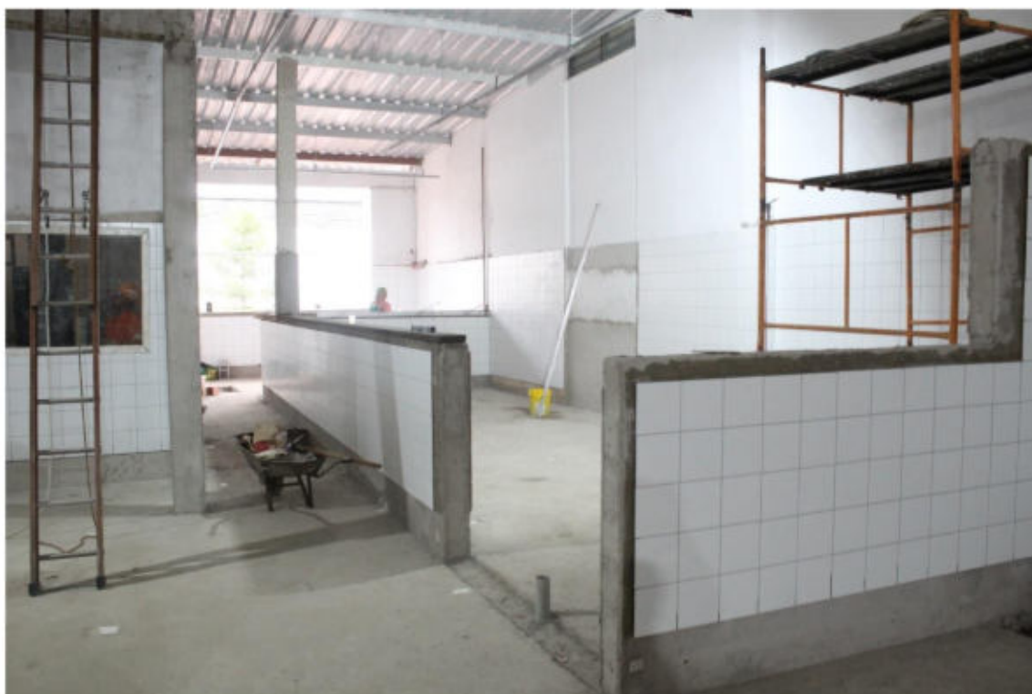
(Cozinha em reforma)
