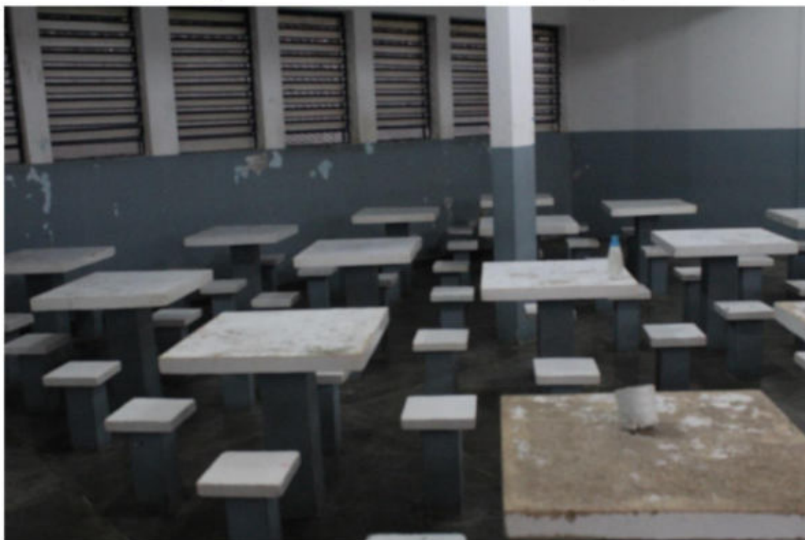
(Refeitório do Pavilhão 4)
