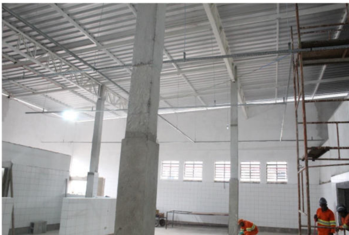
(Cozinha em reforma)
