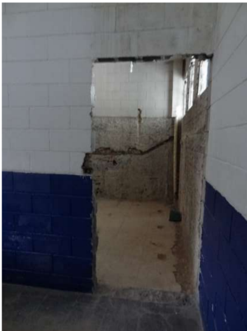
Área para construção de mais videoconferência
