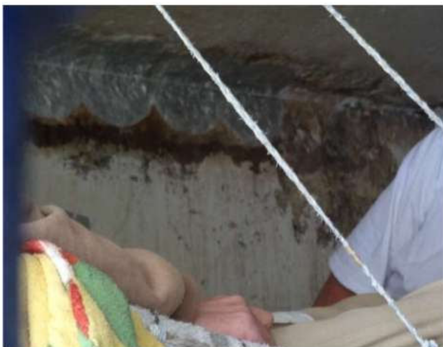
Infiltrações nas celas dos raios 1 e 6
