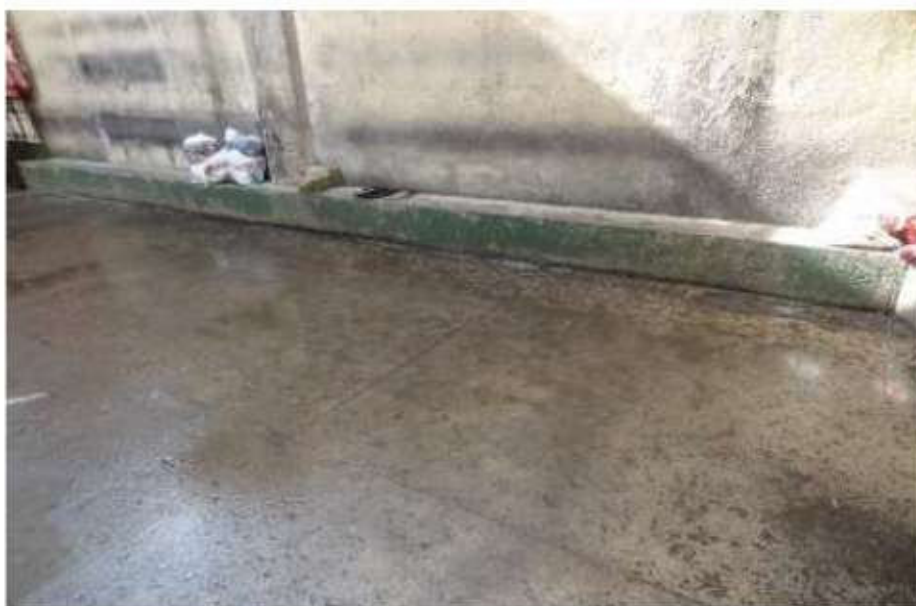
Infiltrações nas celas dos raios 1 e 6
