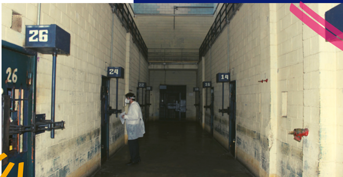
Foto 16 - P Masculina de Sorocaba II - 22/6/20 - Defensor conversando com pessoas presas. Observam-se portas chapeadas, instalações sem qualquer ventilação e iluminação insuficiente.
