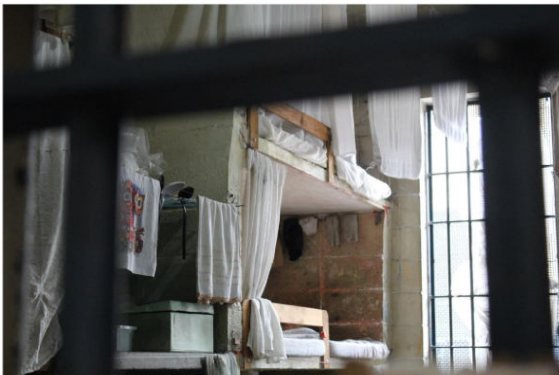
(celas de idosos pavilhão II – guardas de proteção contra quedas)
